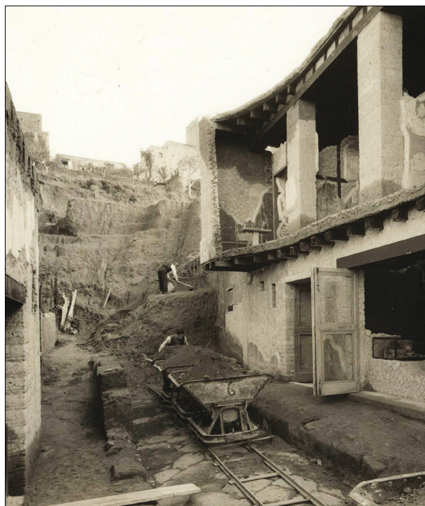
Fig. 354. Scavo di A. Maiuri lungo il Cardo IV di Ercolano, 1933; in primo piano i carrelli Decauville (da CAMARDO, NOTOMISTA 2017).
