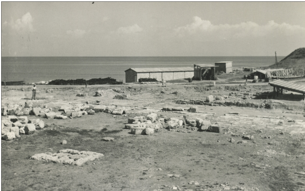
Fig. 275. Veduta da ovest del complesso monumentale forense al termine dell'intervento di G. Pesce; in basso a sinistra si nota il basamento posto al centro della piazza e probabilmente destinato a un monumento equestre (SABAP; archivio fotografico; inv. 4831).
