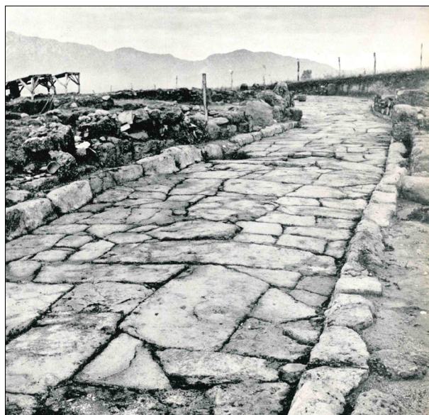
Fig. 263. Il basolato della via EF , pochi anni dopo essere stato esposto dagli scavi di G. Pesce (da SERRA M. 1958b, fig. 72 f.t.).
