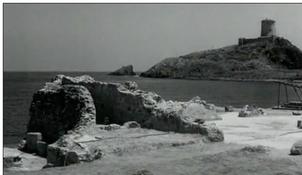
Fig. 328. Fotogramma di Sardegna quasi un continente (1961); si distinguono vari apprestamenti da mettere in relazione con le attività di scavo e consolidamento dell'edificio (Sardegna Digital Library; collezione Archivi della Memoria; raccolta Archivio Rai).
