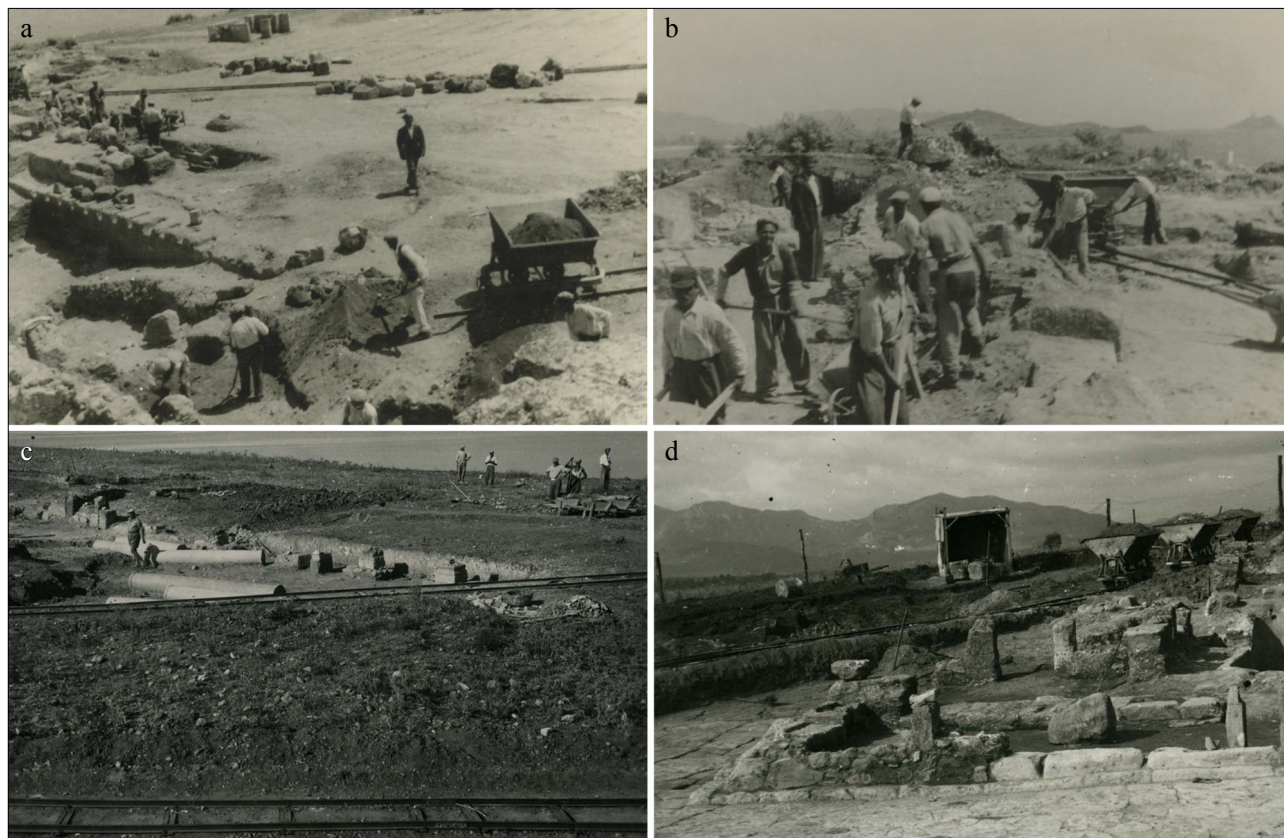
Fig. 355. Linee di carrelli Decauville a Nora: a) presso il teatro (1952, VII.F159), b) il Tempio romano (1952, VII.F167), c) la casa dell’Atrio tetrastilo (1953, VII.F31), d) le pendici sud-occidentali del colle di Tanit (1954, VII.F102).
