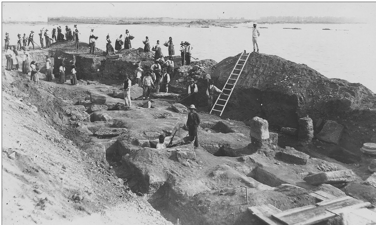
Fig. 131. Foto dell'area di scavo della necropoli punica nel 1891, vista da sud (IV.F5).
