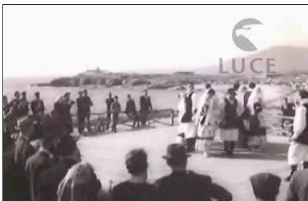
Fig. 341. Fotogramma di uno spettacolo folkloristico allestito dall'ESIT nel 1962 sulla piattaforma installata nell'area a est del foro (Archivio storico Istituto Luce; Archivio Cinematografico; CM031002).
