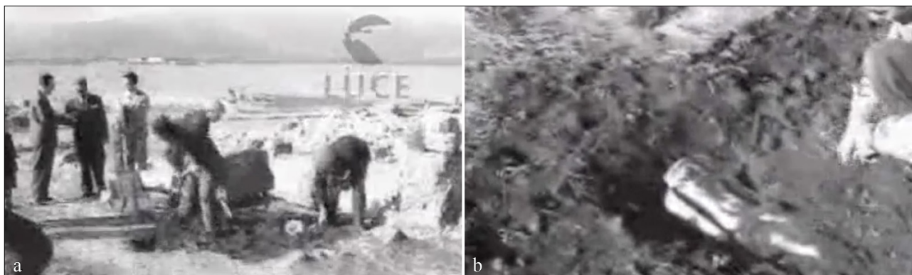
Fig. 322. Due fotogrammi di un cinegiornale del 1959 che documentano gli scavi in corso presso l' horreum/insula : a) attività di scavo tra il tratto occidentale del corridoio A11 e i vani A13 e A21 ; b) anfora Dressel 1 (?) esposta nell'ambiente A21 (Archivio storico Istituto Luce; Archivio Cinematografico; OC013403).
