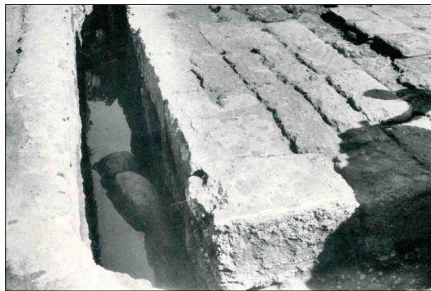
Fig. 292. Platea di fondazione delle Terme Centrali, realizzata in grandi blocchi di arenaria squadrati, che Pesce riteneva basamento di un tempio punico precedente all'edificio termale (da PESCE 1957a, fig. 28 f.t. = PESCE 1961a, fig. 61 f.t. = PESCE 2000 2 , fig. 34, p. 151).
