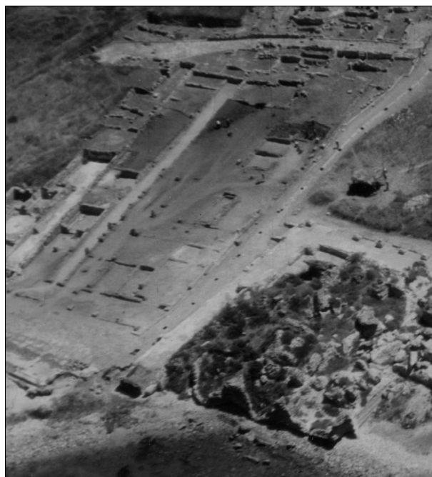
Fig. 321. Veduta aerea dell' horreum/insula in corso di scavo, 1959 (VII.F6, dettaglio).
