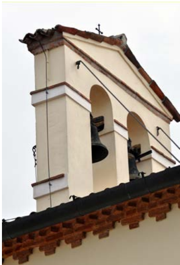
30) Abano Terme (PD), monastero di San Daniele in Monte, campanile.
