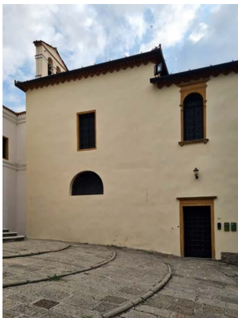
13) Abano Terme (PD), monastero di San Daniele in Monte, angolo nord-occidentale.
