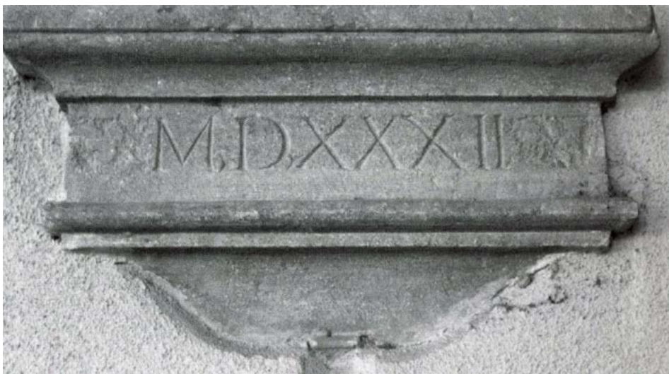
4) Abano Terme (PD), monastero di San Daniele in Monte, chiostro, imposta di una delle crociere maggiori con l'indicazione dell'anno MDXXXII , in Monastero San Daniele in Monte... , cit.
