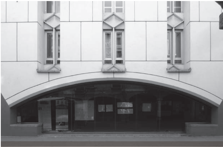
Nuova sede della Banca d'Italia a Padova di Giuseppe Samonà (particolare della galleria) - (Foto di A. Buggin)
