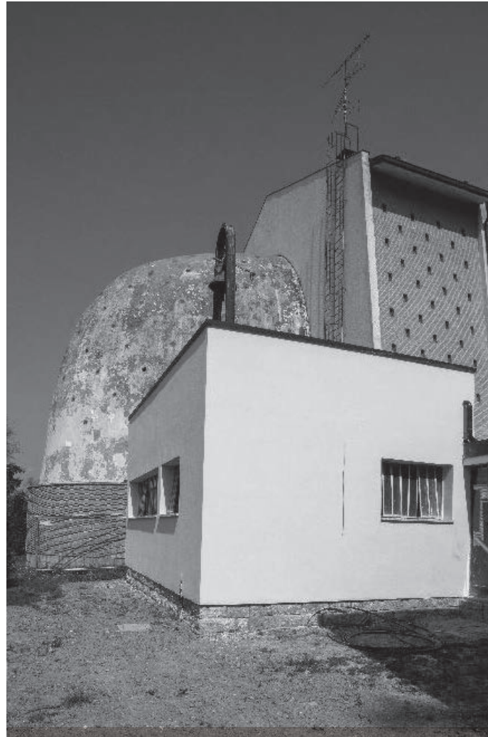
Sergio Pasqualotto, chiesa del Complesso Socio Sanitario dei Colli, Brusegana (1956-1958). Veduta della calotta del presbiterio, dietro al volume della sacrestia. (Foto di Matteo Danesi)
