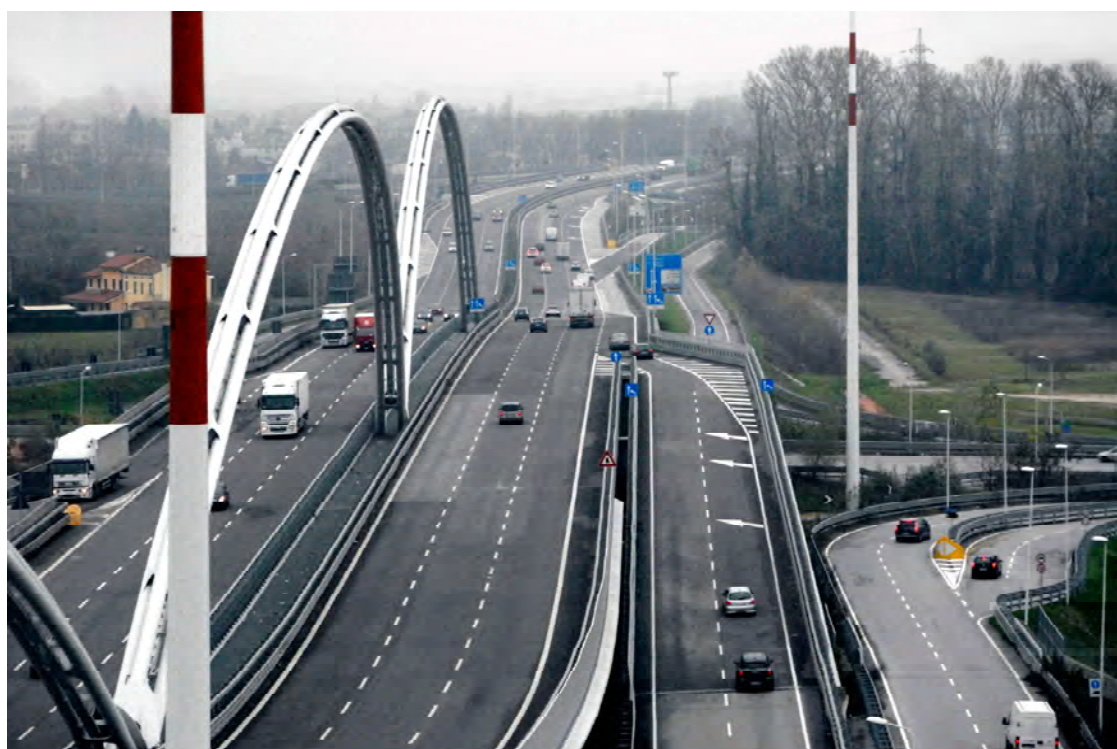
3 e 4 - Autostrada A4 Milano-Venezia, casello autostradale Padova Est, Ponte Darwin, dicembre 2014.
