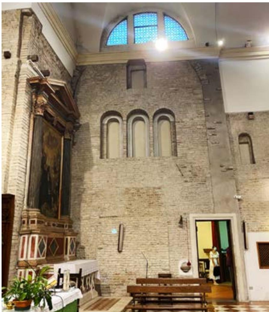
Per quanto riguarda gli indizi strutturali utili ad avanzare un'ipotesi sulla copertura, è stato rilevato che nel possibile intervento duecentesco gli alzati furono sopraelevati di circa 1,60 mt. – come dimostrato dall'aggiunta di una differente tipologia di mattoni – e si legge l'accento di una volta da cui, secondo un'ipotesi a dir la verità difficile da dimostrare, sarebbe stata eretta una cupola sferica<sup>16</sup>. Di grande importanza fu poi il ritrovamento
