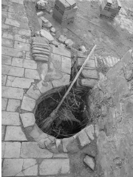
Fig. 10 Agóst: pozzetto per il recupero dell'acqua dalle vasche di decantazione nell'impianto di Tomàs.
