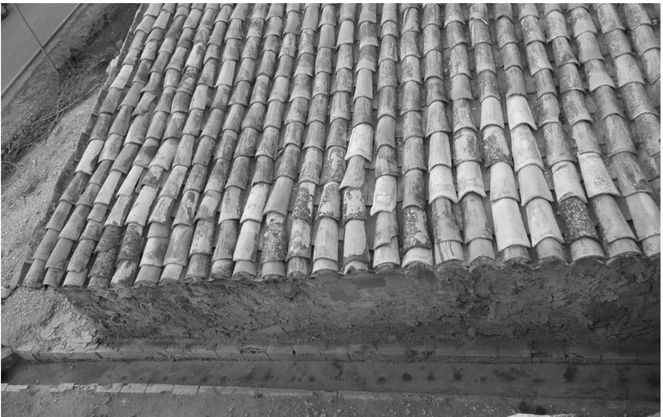
Fig. 9 Agóst: canaletta in laterizio che raccoglie l'acqua piovana dai tetti dell'area di lavorazione dell'argilla e dall'essiccatoio dell'impianto produttivo di Roque.
