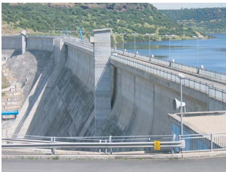
Figura 2.7: Veduta della Diga Cantoniera.
