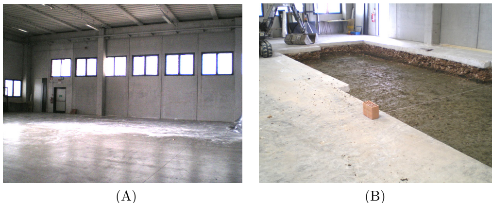
Figura 2.3: (A) sito di costruzione del laboratorio di misura prima dell'esecuzione dei lavori; (B) esecuzione dello scavo per le fondazioni.
