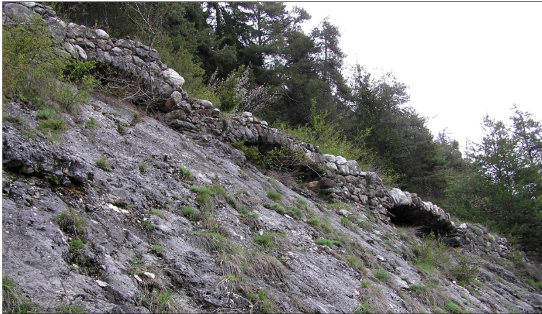
FIG. 19.21 Strada su arcate di Castelfondo (foto B. Ruffini).
