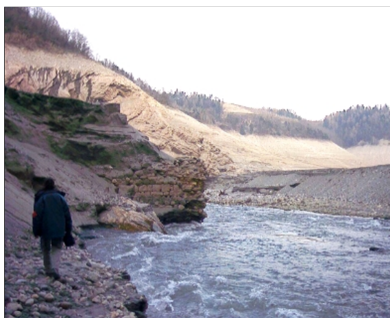
FIG. 19.34 Spalla orientale del "Ponte della Scala" tra Cles ed il Castelàz di Cagnò (anno 2003).
