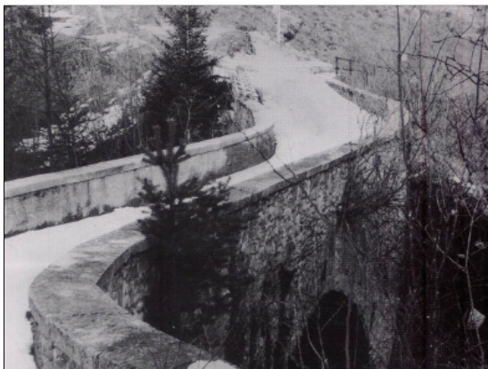
FIG. 19.16 Ponte di Pozzena. Da FAUSTINI 1996, p. 22.
