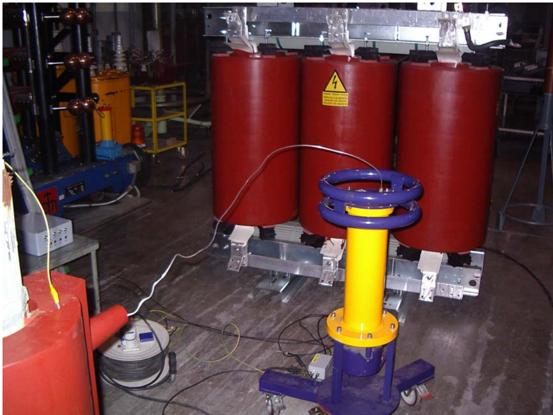
Figura 9-34: Prove eseguite sui trasformatori presso la sala prove del costruttore.
