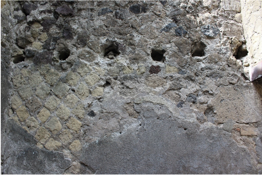
Fig. 41. Casa del Gran Portale, ambiente 7, parete Sud.
