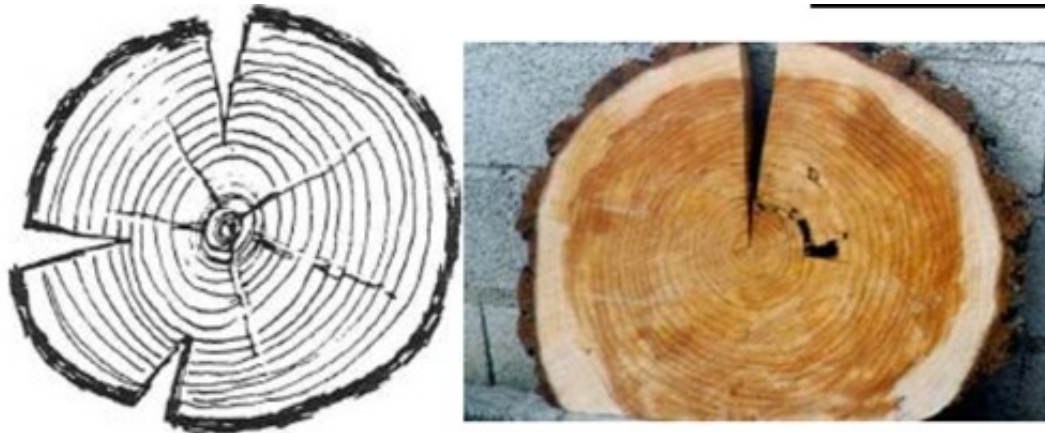
Fig. 5. Fenditure radiali (Biolcati, Rinaldi, ppt del corso di progettazione degli elementi costruttivi, http://www.unife.it/ing/civile/insegnamenti/pec/materiale-didattico-1/pec-401-legno.pdf/view ).
