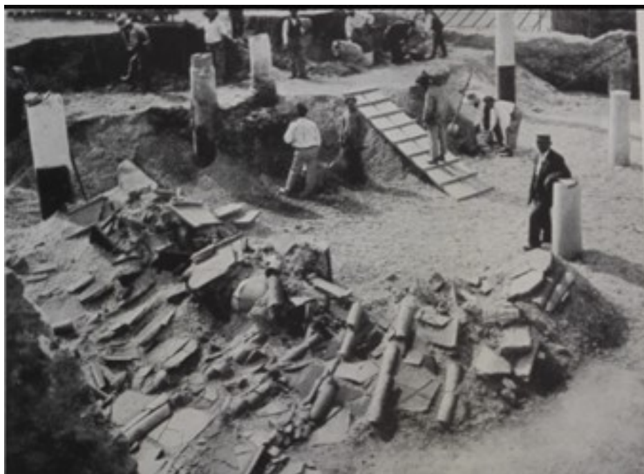
Fig. 10. Tettoia del peristilio della casa di Cuspia Pansa I, VIII, 1 (da Spinazzola 1953, p. 38, fig. 34).
