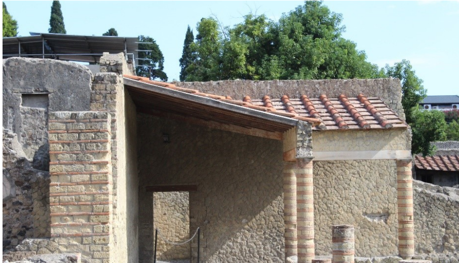
Fig. 24. Portico ricostruito ad Ercolano nel quale le travi si incastrano nella muratura presenti sulle colonne (foto dell'autore).
