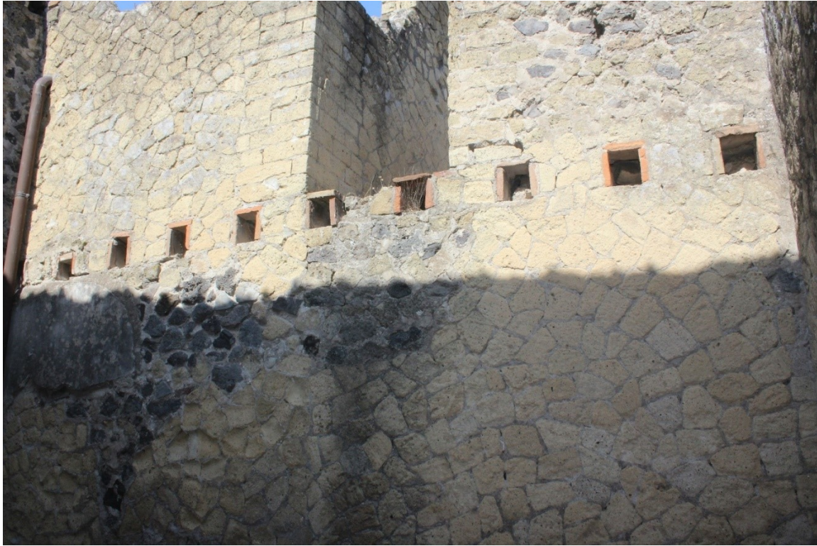
Fig. 18. Casa dell'alcova, ambiente 18, parete Nord.
