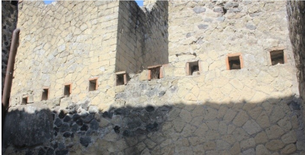
Fig. 5. Ercolano, Casa dell'alcova, fori delimitati da laterizi (foto dell'autore).
