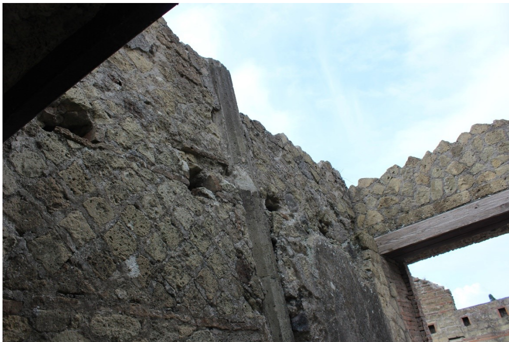
Fig. 40. Casa del Gran Portale, fauces, parete Est.
