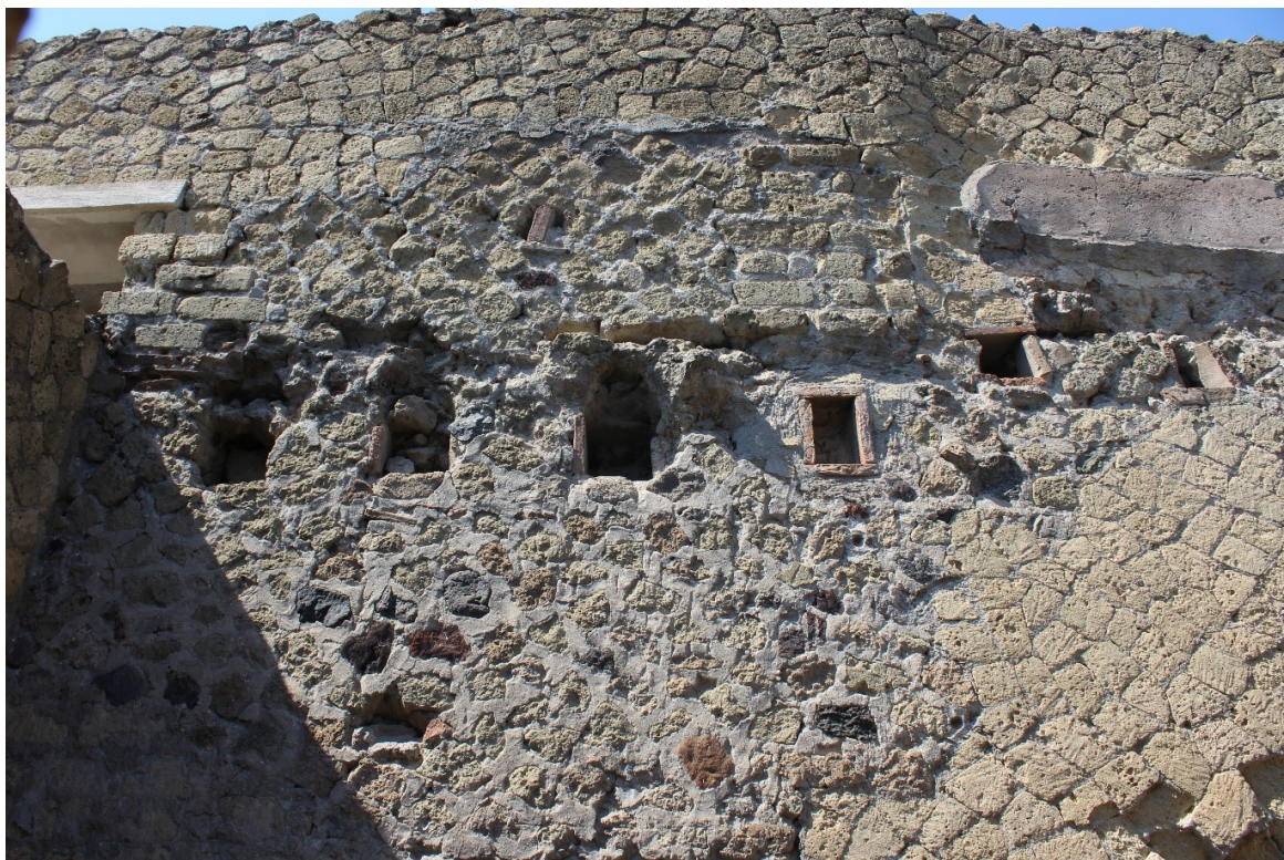
Fig. 61. Ingresso 13, ambiente 2, parete Ovest.
