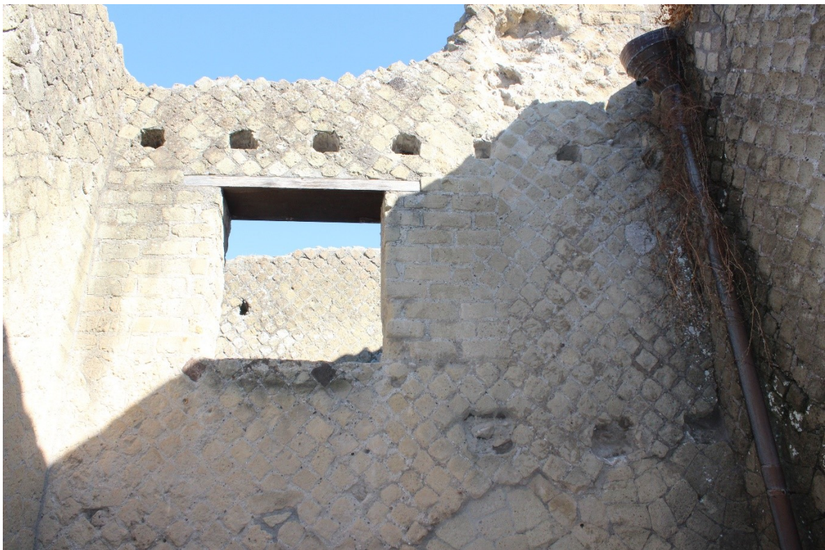
Fig. 51. Casa del Salone Nero, ambiente C-secondo piano, parete Nord.
