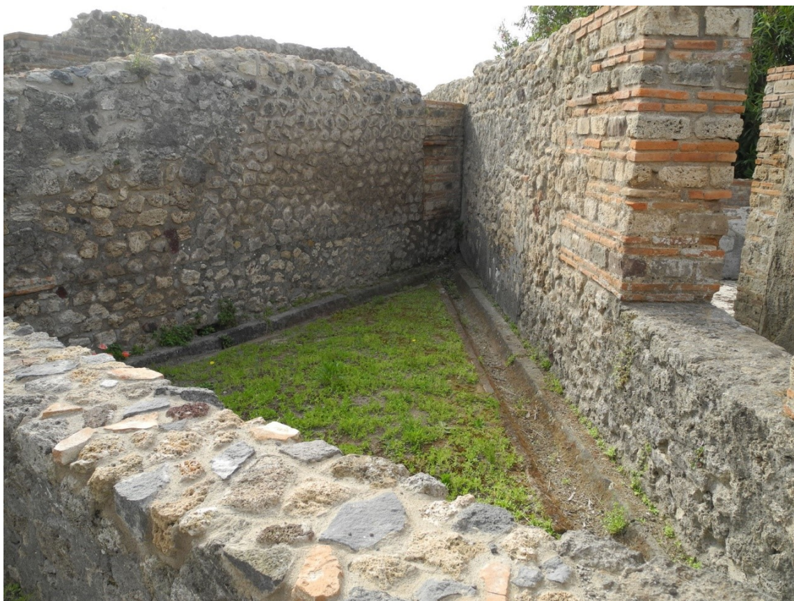
Fig. 23. Pozzo di luce "h".
