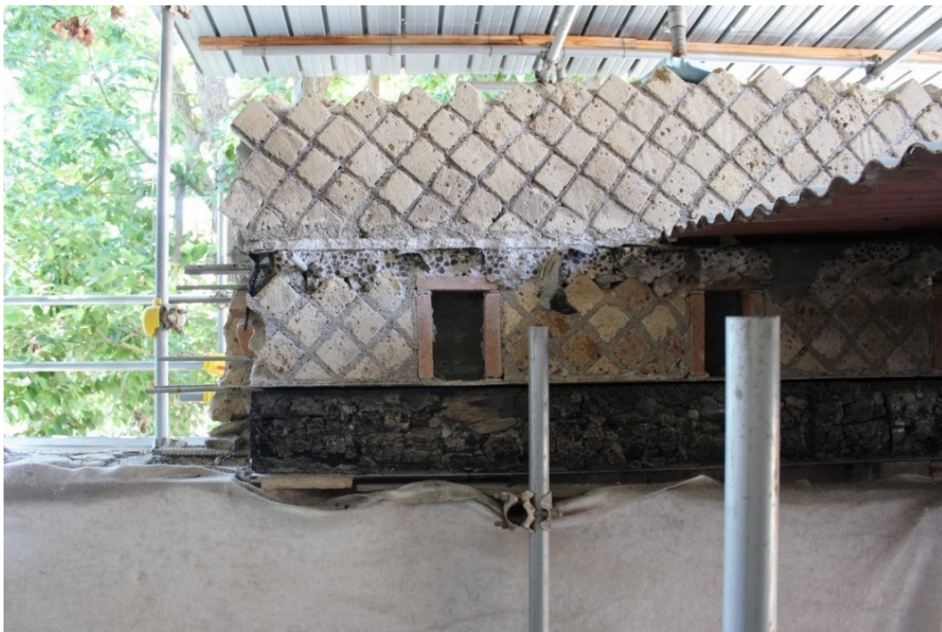
Fig. 8. Casa dell'atrio a mosaico, dormiente inserito nella muratura (foto dell'autore).
