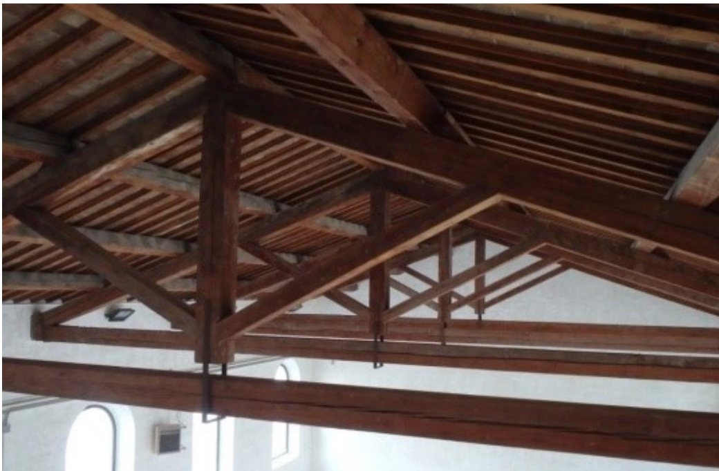
Fig. 28. In questa capriata il monaco è staccato dalla catena, ma i due elementi sono collegati da una staffa metallica (immagine tratta www.ingegneriaedintorni.com ).
