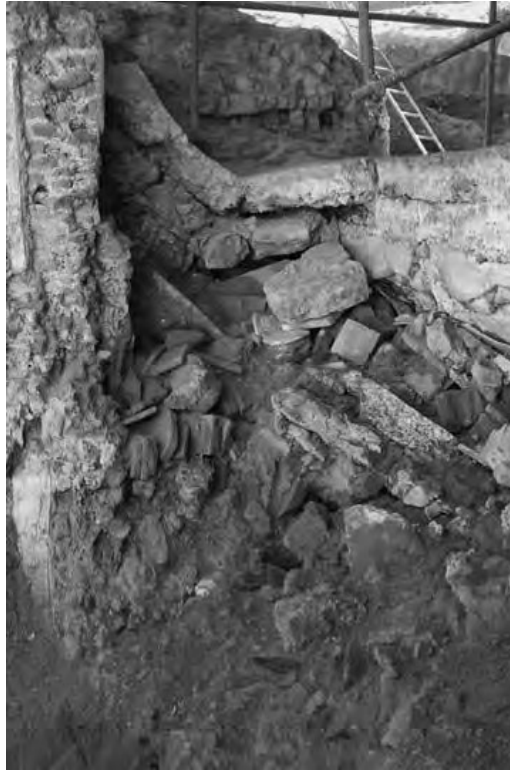
Fig. 39. Dettaglio del crollo del solaio della terrazza ISAH (f) (immagine tratta da Guidobaldi et alii 2009, p. 64, fig. 20).
