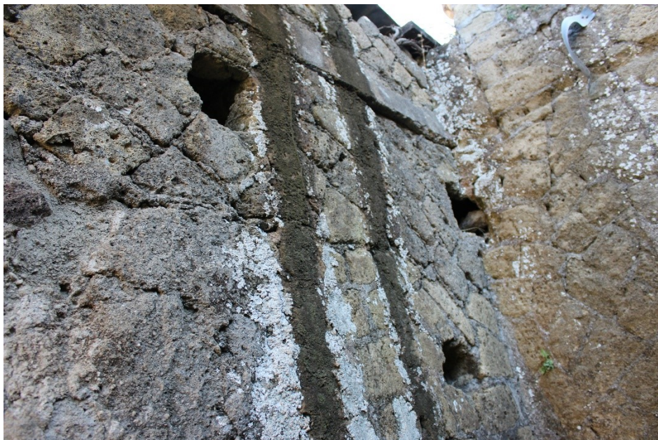
Fig. 10. Casa dell'Ara laterizia, ambiente B, parete Nord.
