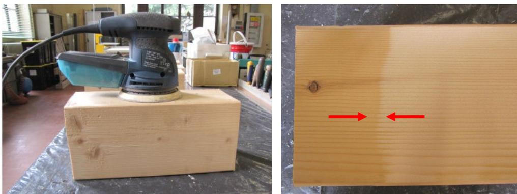
Figura 4.7: Rimozione con carta abrasiva dello strato di ossidazione superficiale.
