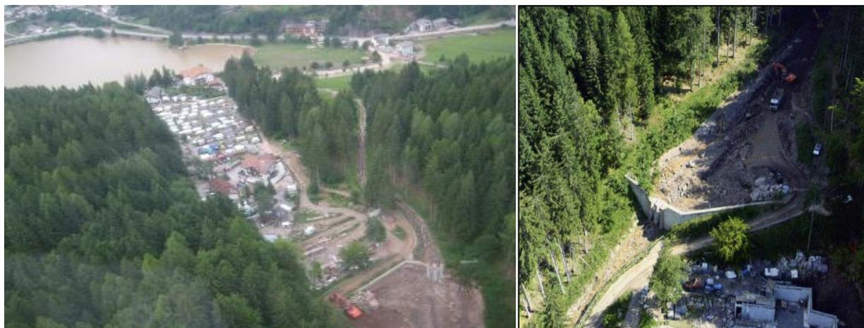
**Fig. 3-14. Nella foto a sinistra: conoide del rio Val del Lago, in basso sulla destra è visibile la briglia filtrante, la piazza di deposito ed il collettore artificiale. Sulla sinistra del conoide sono visibili il campeggio e l'albergo (foto PAT). Nella foto a destra piazza di deposito del rio Val del Lago durante lo sgombero.**
