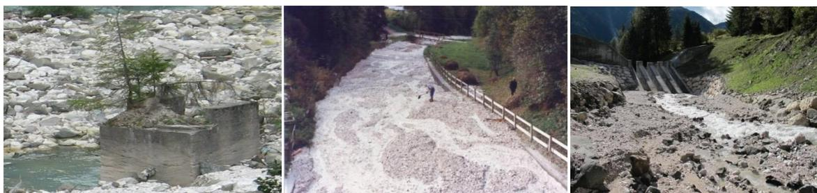
**Fig. 3-10: a sinistra il masso trasportato dal Rudan fino alla confluenza con il torrente Boite dall'evento del 1882, al centro il canale a valle della S.S. Alemagna completamente colmato dalle deposizioni della colata detritica del 1999, a destra la piazza di deposito e la briglia filtrante, vista da monte, realizzata nel 2011.**
