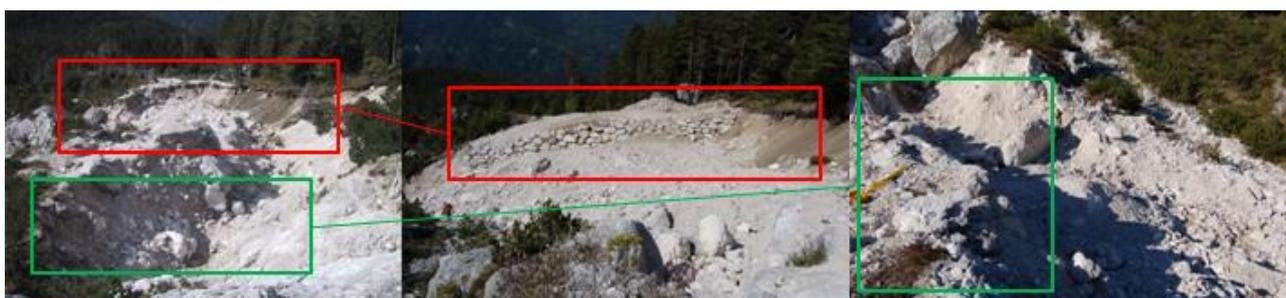
**Fig. 3-11: a destra l'ansa a quota 1590 nel 2001, al centro nel riquadro rosso la sistemazione dell'ansa stessa con scogliera in massi ciclopici, e a destra, posta a monte della stessa (riquadro verde), l'altra scogliera posta a rettificare il canale, aperto nei primi metri con mine.**
