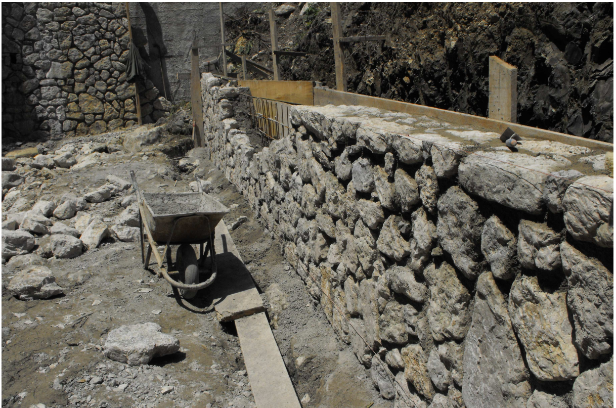
Figura 3 Costruzione di muro in pietrame
