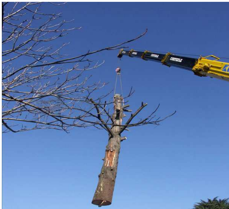
Figura 42 Abbattimento con autogru (3T)
