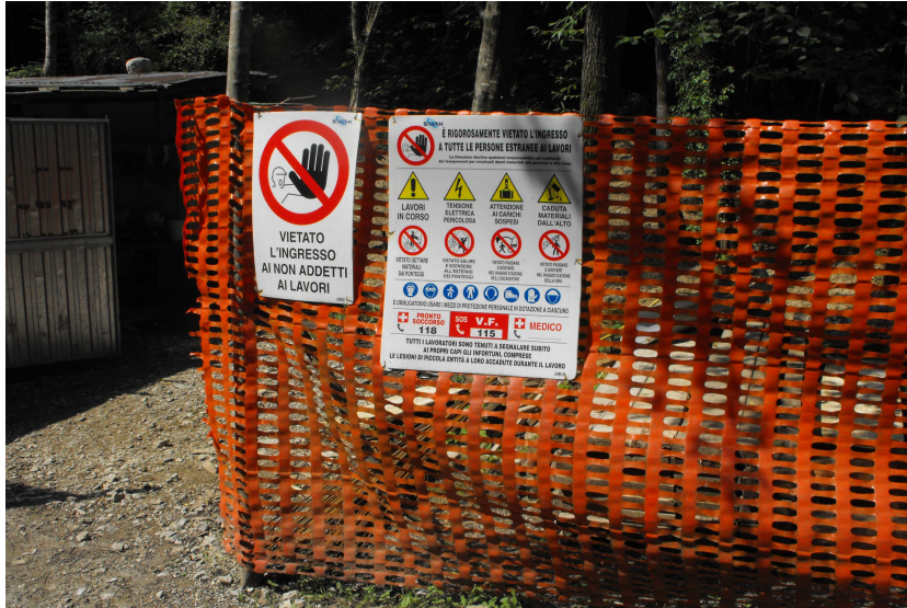
Figura 21 Cartellonistica in cantiere
