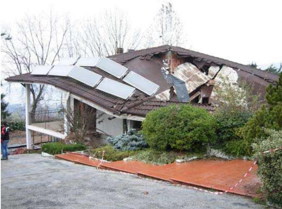
Figura 6 Cedimento dell'abitazione sul lato est.
