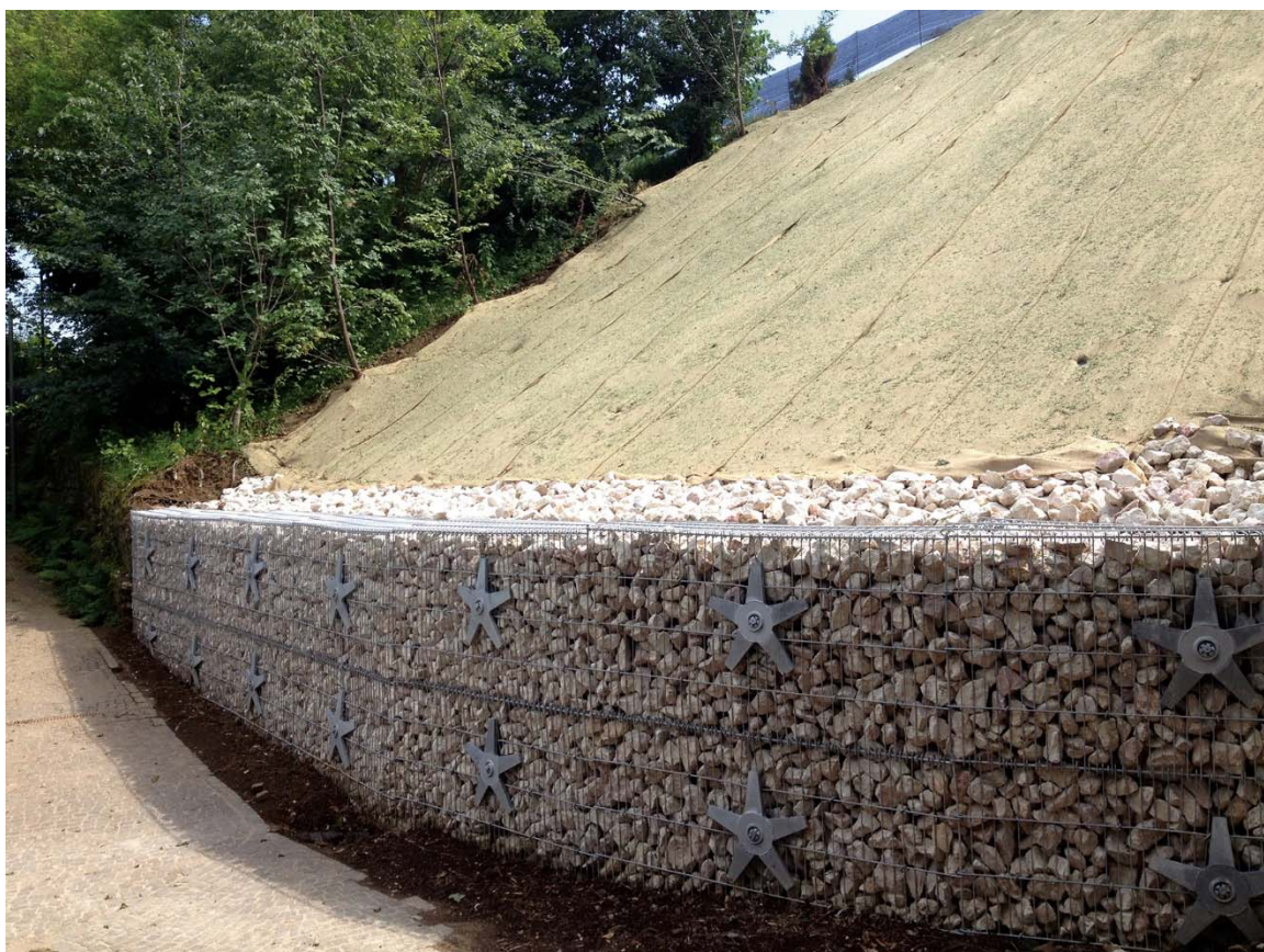
Figura 2.16. Gabbionata con Sirive® Supergabions per stabilizzare il piede di una piccola frana (2014).
