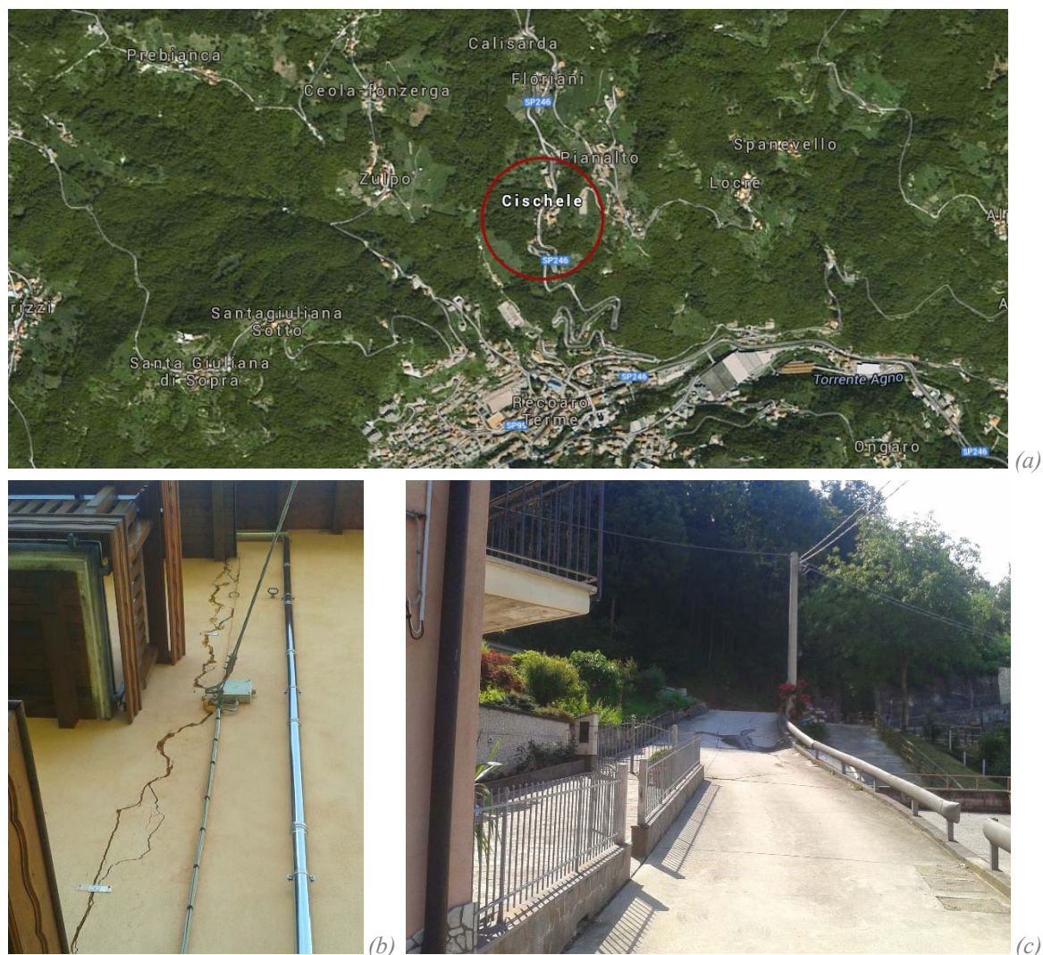
Figura 7.29. Frana Cischele a Recoaro Terme: vista satellitare dell’area interessata (Google Earth) (a); lesioni in un’abitazione (b) e nella strada di accesso (c).
