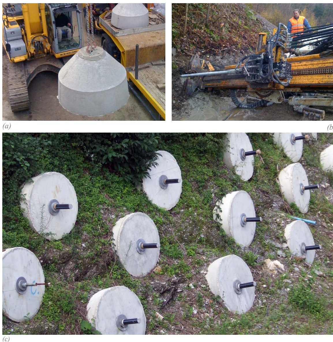
Figura 7.6. Lavori di consolidamento di frana Gisbenti: trasporto delle piastre flottanti prefabbricate a geometria tronco-conica (a), esecuzione degli ancoraggi passivi con tecnologia autoporforante (b), foto a intervento finito (c).
