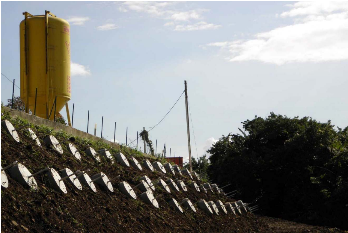
Figura 3.12. Intervento con cintura flottante su frana di Via Monte, Cornedo Vicentino (VI).
