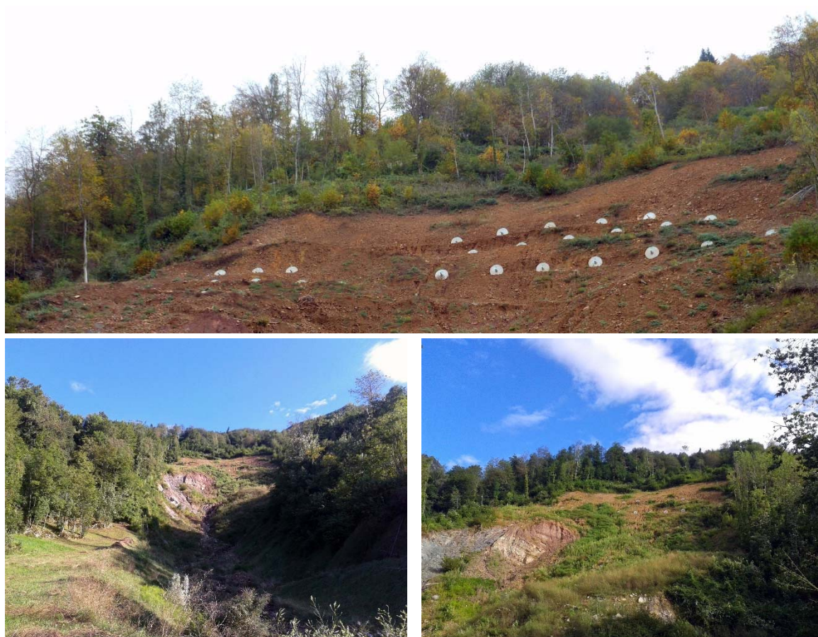
Figura 7.28. Frana di Val Maso allo stato attuale (dicembre 2014).
