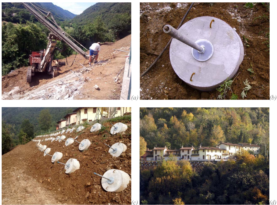
Figura 7.12. Frana di Via Monte a Cornedo Vicentino (VI): installazione dei rinforzi (a), particolare di una piastra flottante (b), intervento finito (c) e vista d'insieme (d).
