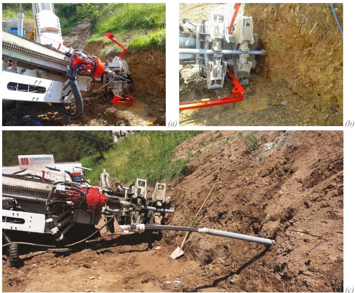
Figura 7.34. Esecuzione di ancoraggi flottanti a frana Cischele: fase di perforazione (a, b); particolare degli ancoraggi composti (c).
