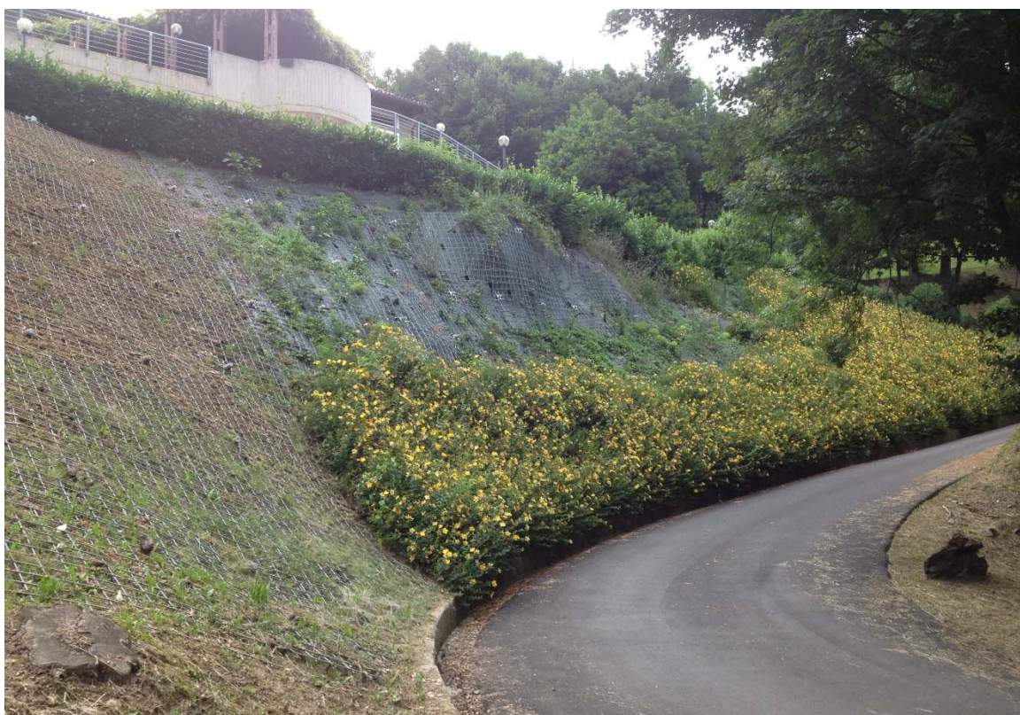
Figura 2.18. Parete chiodata a verde eseguita con tecnica Sirive-I (2013).
