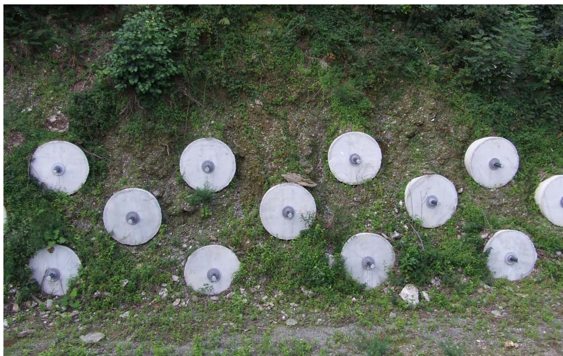
Figura 3.13. Intervento con cintura flottante su frana Gisbenti, Valli del Pasubio (VI).
