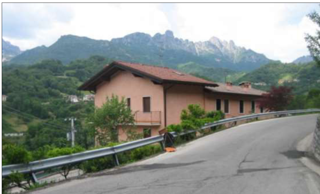
Figura 48 Tratto di strada SP 246 interessato dal dissesto.
