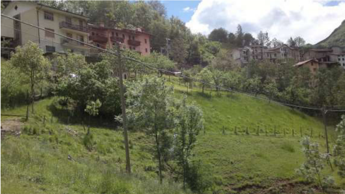
Figura 52 Versante interessato dal fenomeno franoso.
