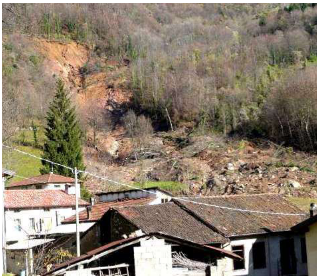
Figura 77 Dissesto franoso, Val di Maso, Valli del Pasubio
