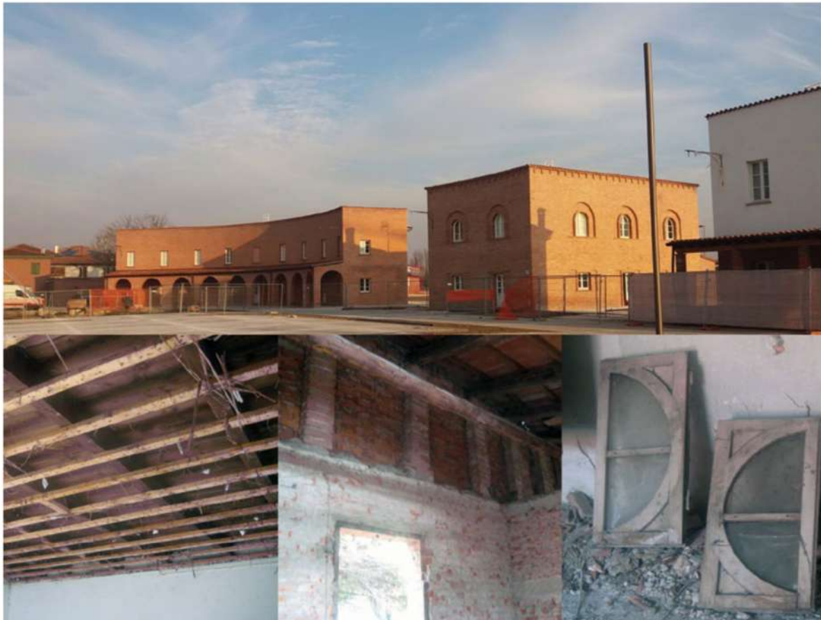
5: Le case rurali di Vigonza al termine dell'intervento di recupero, stralcio iniziale: veduta dei primi edifici da est (foto del novembre 2015). Le facciate sulla piazza sono in laterizio a vista con l'esclusione della porzione corrispondente al piano superiore del fabbricato con andamento convesso (a destra, in parte fuori quadro). Particolari della situazione di origine: i solai in legno intermedi, la muratura che regge le travi del tetto ad una sola falda, gli infissi in legno dipinto di bianco [Fotografie dell'autore].
