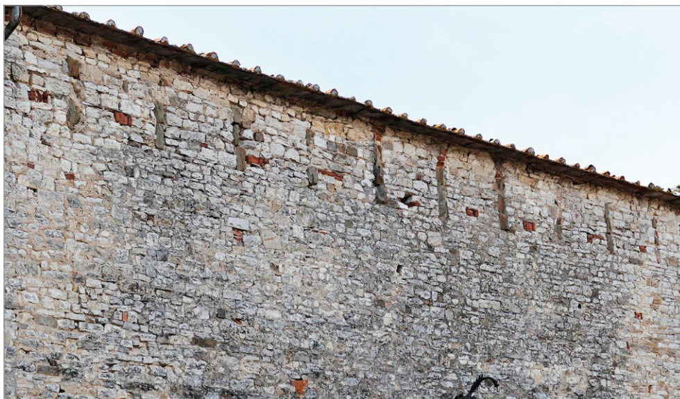
fig. 134 – Poggio a Luco: particolare dei beccatelli.
