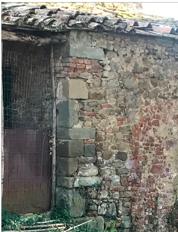
fig. 75 – Fonte S. Martino: particolare dell'angolata in conci squadrati di recupero in un casolare vicino al sito di Ripacozza, di cui forse ha reimpiegato le pietre.
