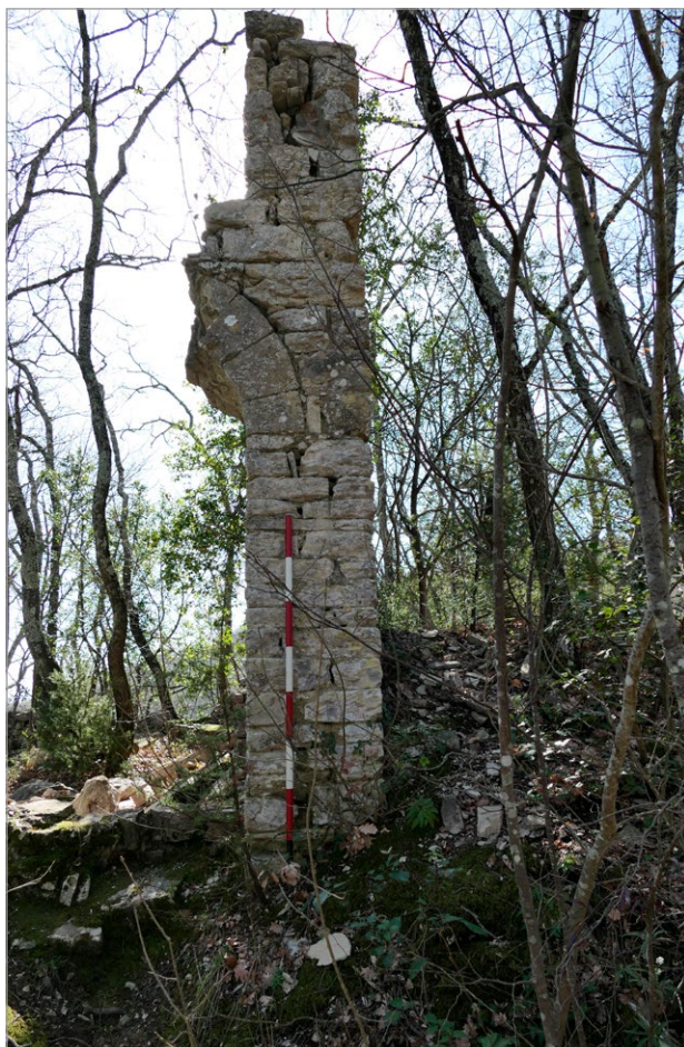
fig. 30 – Monastero di Casignano: resti del portale di accesso secondario, situato nell'angolo nord-ovest del monastero.
