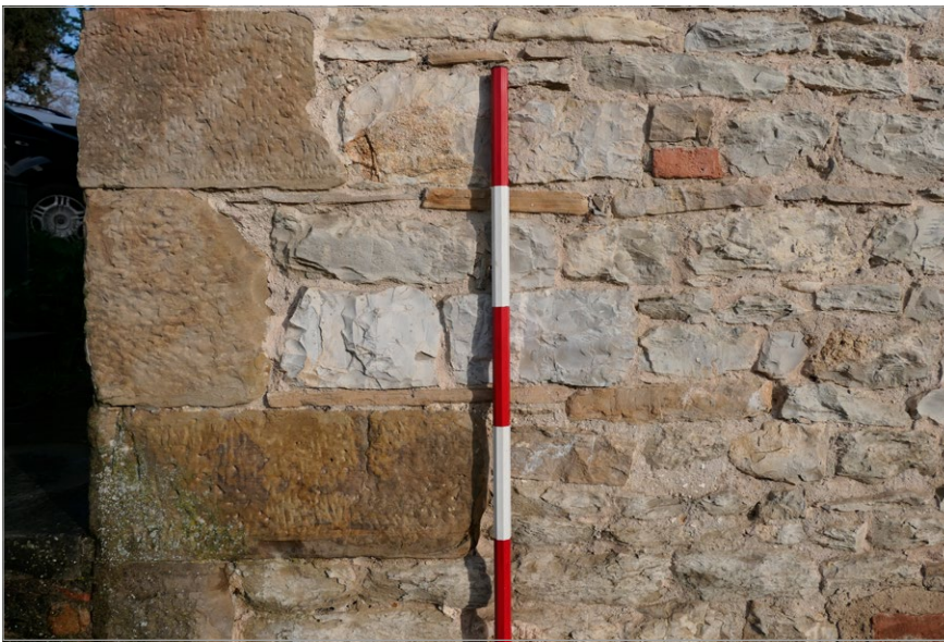
fig. 137 – Antella, pieve di S. Maria: particolare del paramento interno in conci di calcare spianati con uno strumento a lama e con il ‘nastrino’ perimetrale lavorato a scalpello.
