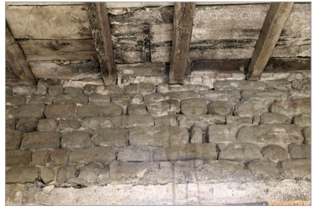
fig. 80 – Gavignano: particolare del paramento in arenaria macigno della residenza signorile di prima metà XIV secolo.
