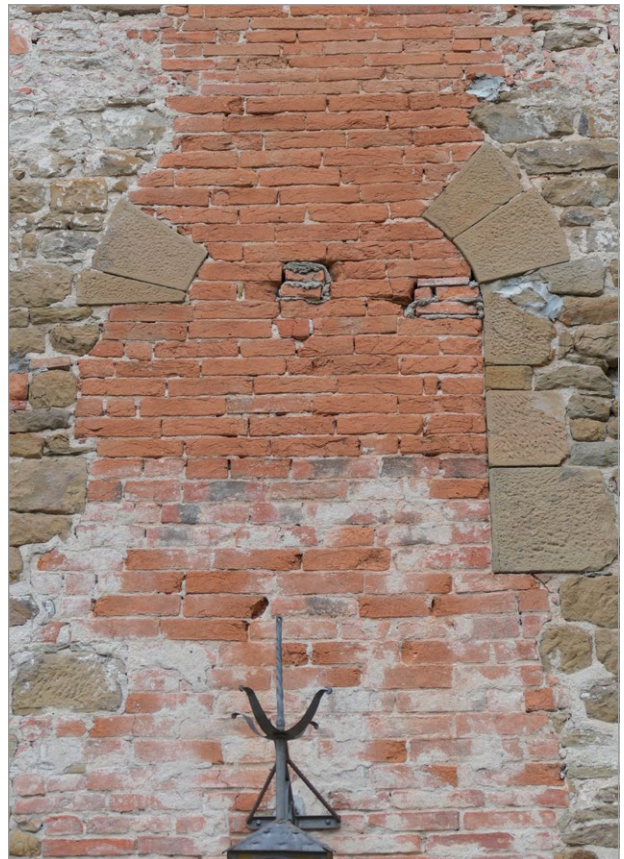
fig. 120 – Palagio di Quarate: particolare della finestra tagliata per l'inserimento di una canna fumaria più tarda.
