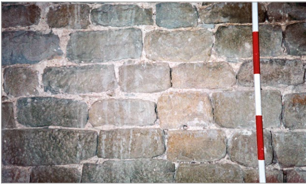
fig. 148 – Montemasso: particolare della muratura della torre prima dei restauri (Tipo 4).
