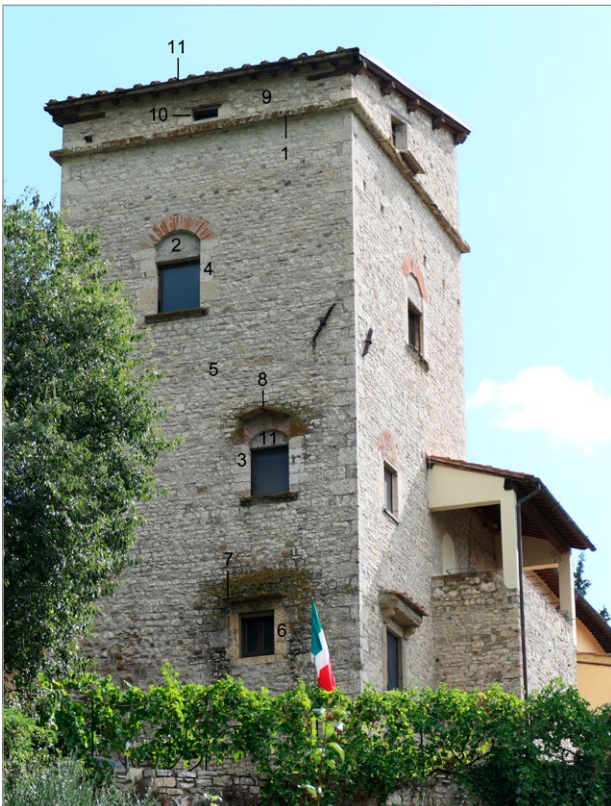
fig. 95 – Torre Terigi: individuazione delle principali unità stratigrafiche murarie nel lato ovest della torre.
