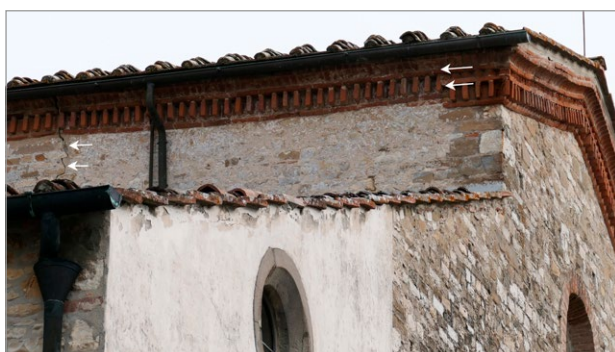
fig. 48 – Pieve di S. Donnino a Villamagna: rifacimento nella muratura della prima campata del cleristorio (in evidenza i punti di discontinuità nella muratura e nella cornice superiore).
