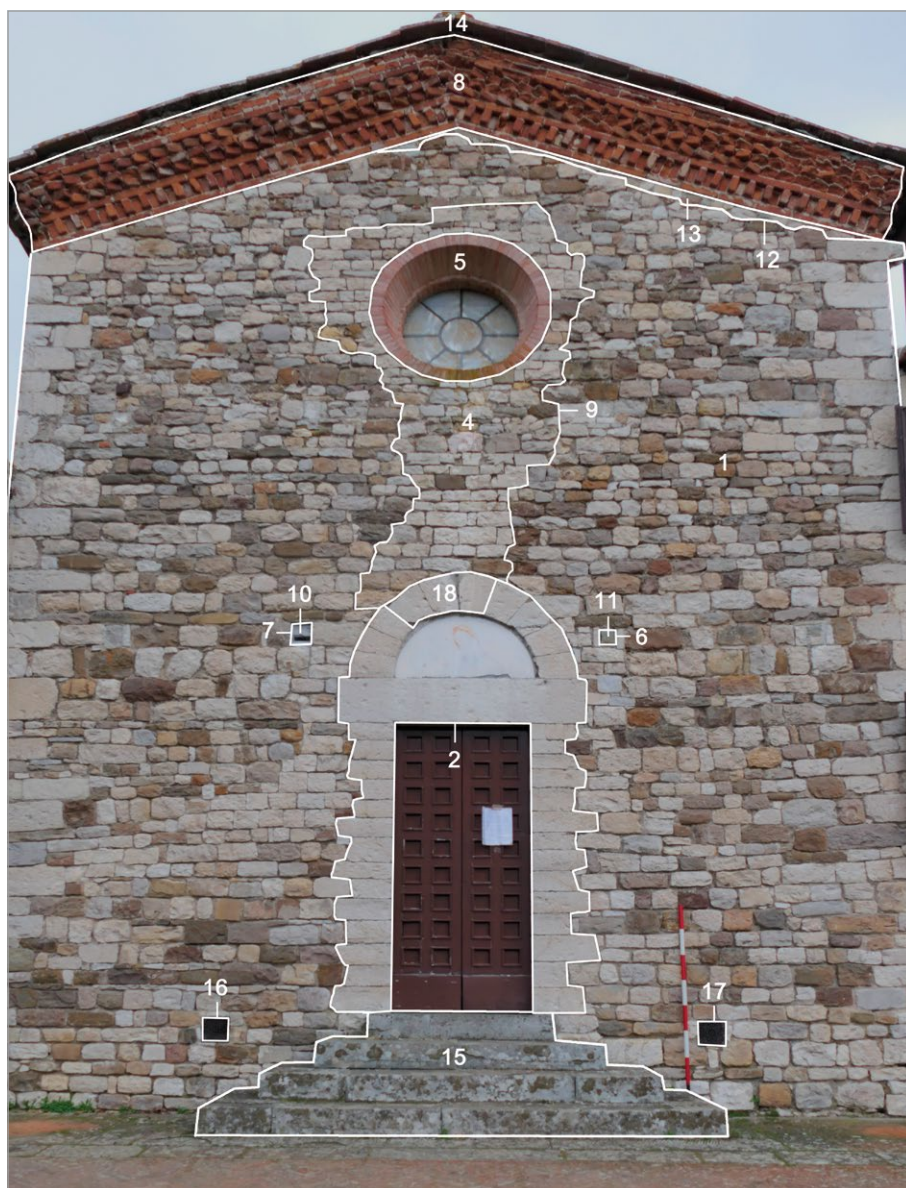
fig. 64 – Chiesa di S. Tommaso a Baroncelli: analisi stratigrafica del prospetto di facciata.
