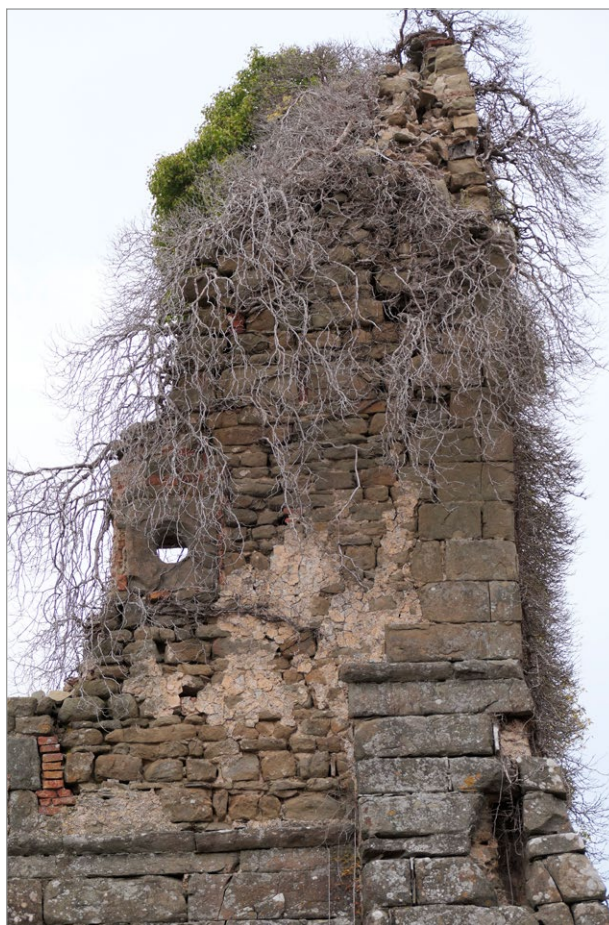
fig. 128 – Palazzaccio a Marcignano: la parte superiore della torre (CF 1) conserva la muratura in arenaria macigno della struttura originaria.
