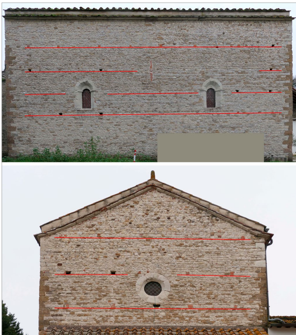
fig. 107 – Oratorio di S. Caterina: gli allineamenti dei ponteggi impiegati per la costruzione visibili in facciata e nel fianco nord.
