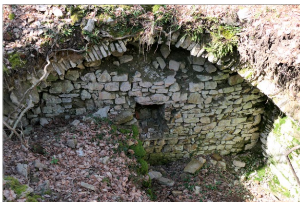
fig. 28 – Monastero di Casignano: l'ambiente sotterraneo, coperto con volta a botte.
