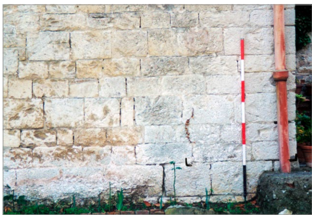
fig. 140 – Particolare del paramento murario dell'oratorio di S. Iacopo a Montacuto (Tipo 1).
