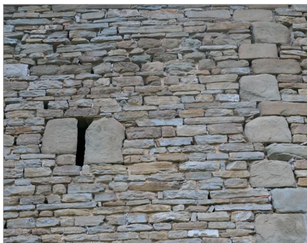
fig. 141 – Gavignano: particolare del diverso grado di finitura tra paramento (Tipo 5) e elementi architettonici.
