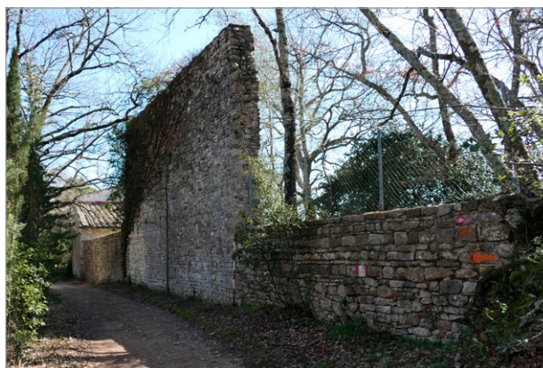
fig. 29 – Monastero di Casignano: il muro perimetrale nord.
