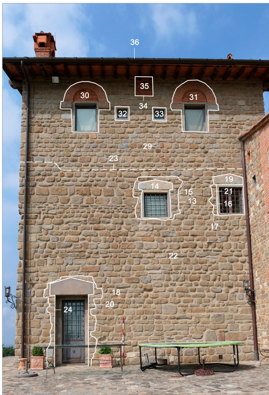
fig. 90 – Montemasso: analisi stratigrafica del prospetto esterno est della casatorre (CF 1): a tratteggio è segnata la quota della parte ricostruita.
