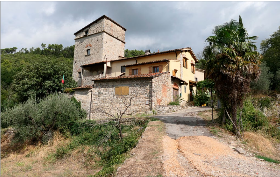
fig. 94 – Torre Terigi: veduta d'insieme.
