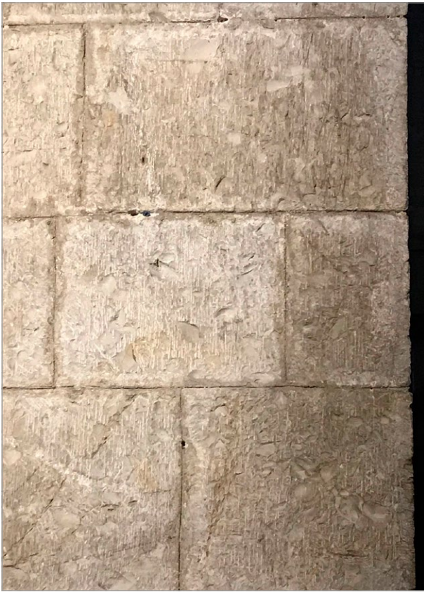
fig. 137 – Antella, pieve di S. Maria: particolare del paramento interno in conci di calcare spianati con uno strumento a lama e con il ‘nastrino’ perimetrale lavorato a scalpello.
