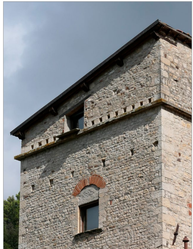
fig. 96 – Torre Terigi: la parte superiore della torre, sopraelevata per realizzarvi una colombaia.
