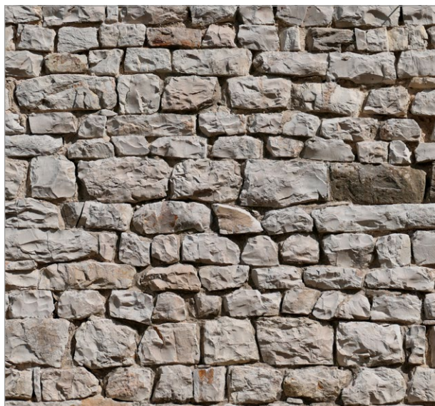
fig. 144 – Particolare della tecnica muraria impiegata nell'oratorio di S. Gherardo a Villamagna (Tipo 3).
