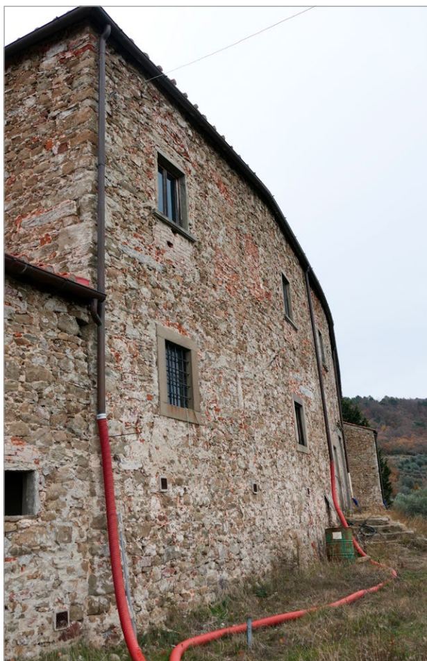
fig. 68 – Montisoni: il fianco della chiesa di S. Lorenzo impostato sul muro di cinta del castello.
