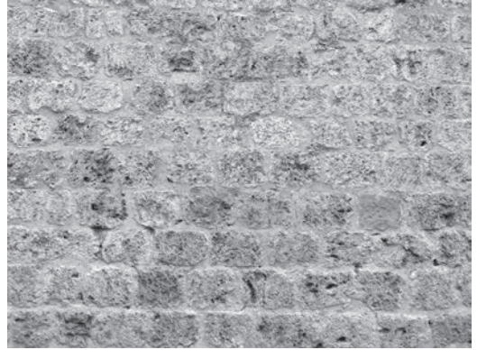
Figura 11. Particolare del paramento murario della torre dei Forteguerri.
