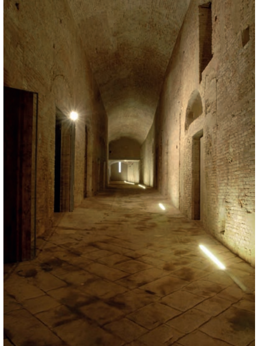
Figura 19. Lungo la cosiddetta 'strada interna' del Santa Maria della Scala sono ancora visibili le facciate delle case del quartiere di Vallepiatta di Sopra, con i portali tamponati, inglobate all'interno dell'ospedale.
