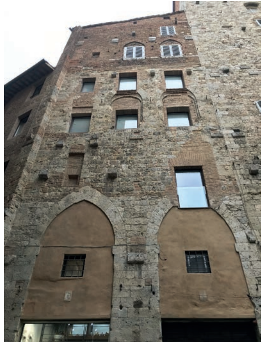
Figura 8. La casa-torre dei Rinuccini.
