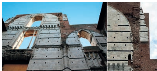
Figura 21. Duomo Nuovo: a sinistra la facciata interna (il cosiddetto 'facciatone'); a destra, particolare del fianco sinistro della navata maggiore con le sole parti a vista rivestite di marmi e il resto lasciato in mattoni.
