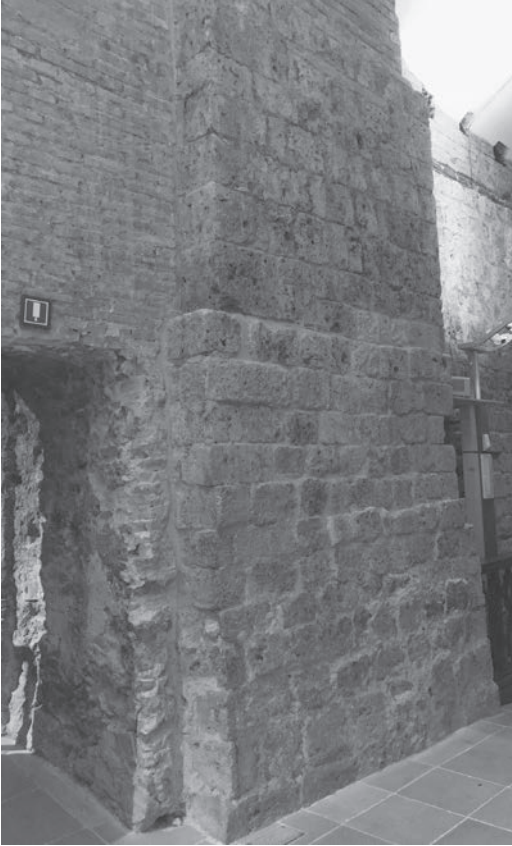
Figura 6. Particolare del pilastro d'angolo, in pietra, del transetto della chiesa di XII secolo.
