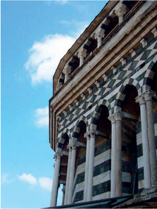
Figura 15. Particolare della loggia della cupola, con il rivestimento marmoreo a fasce alterne.
