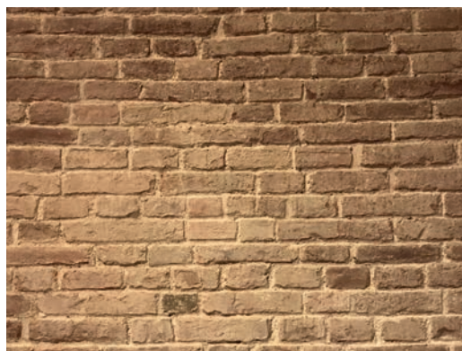
Figura 22. Muratura in laterizi del duomo.
