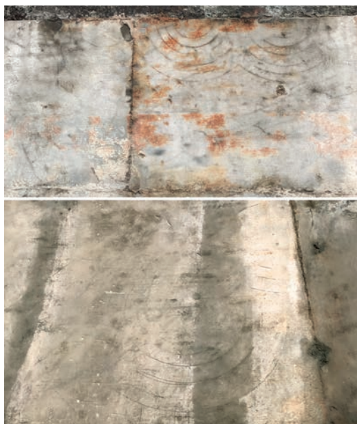
Figura 30. Duomo Nuovo: esempi di segni lapidari ancora visibili sui conci di marmo della navata sud-est.
