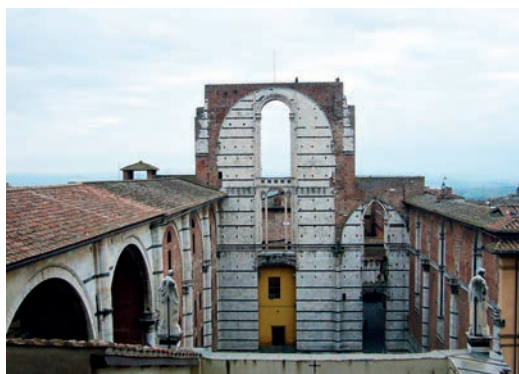
Figura 24. Veduta panoramica delle strutture del Duomo Nuovo.
