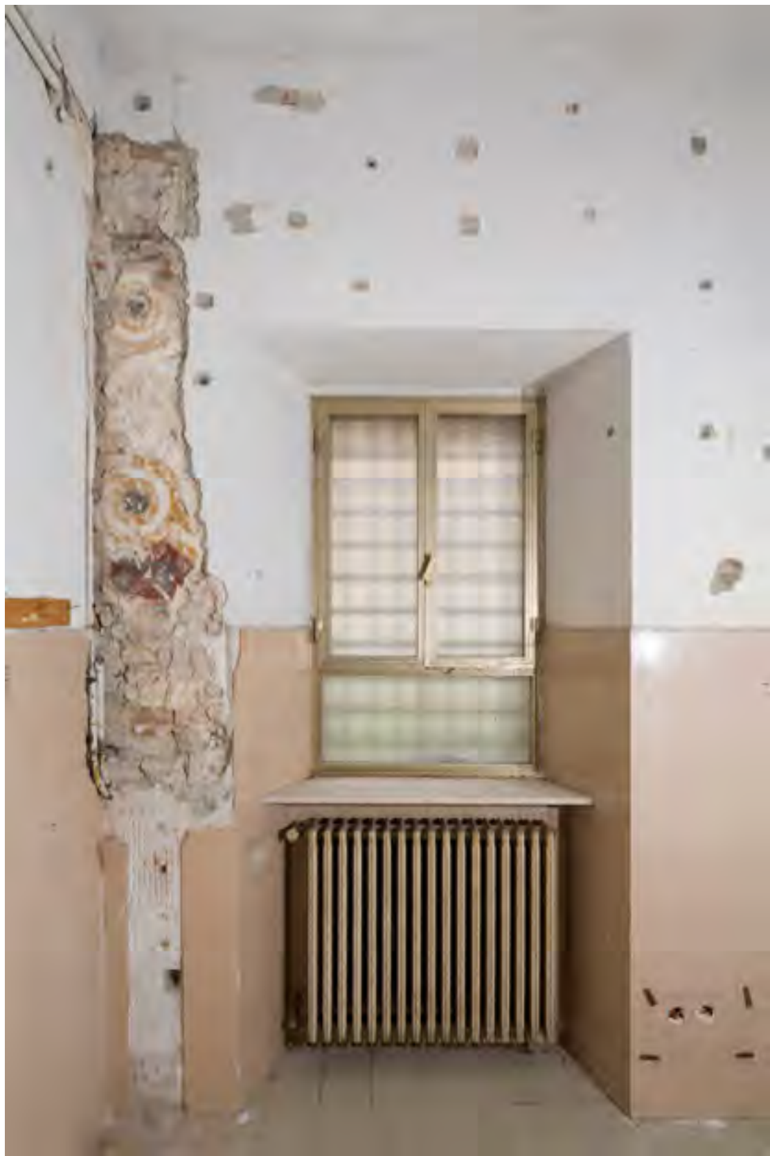
Fig. 89: Padova, castello carrarese, ala orientale, piano terra, loggia, parete orientale.
