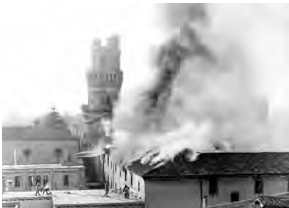
Figg. 168-170: L'ala meridionale del castello durante l'incendio del 3 febbraio 1989.
