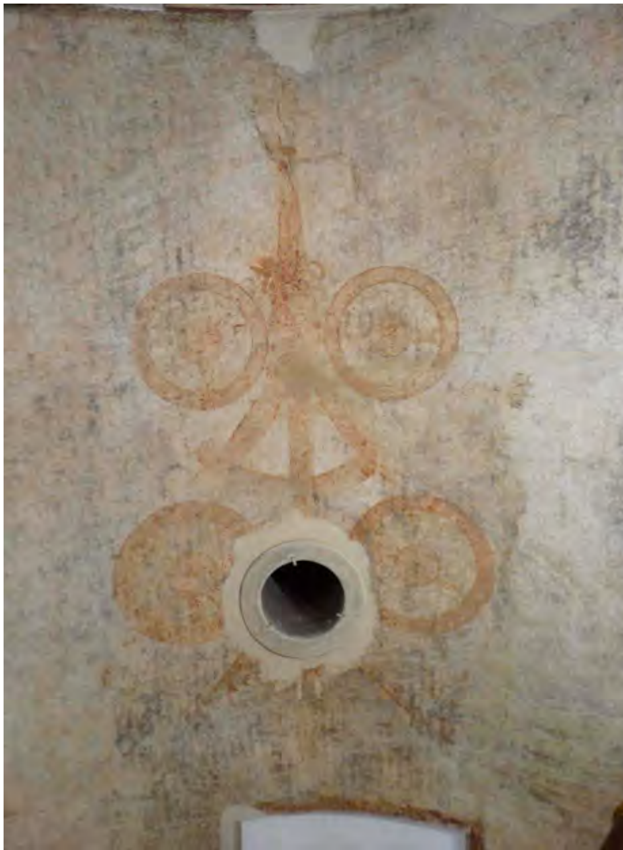
Fig. 160: Padova, castello carrarese, Torlonga, piano primo, Camera delle polveri , volta.
