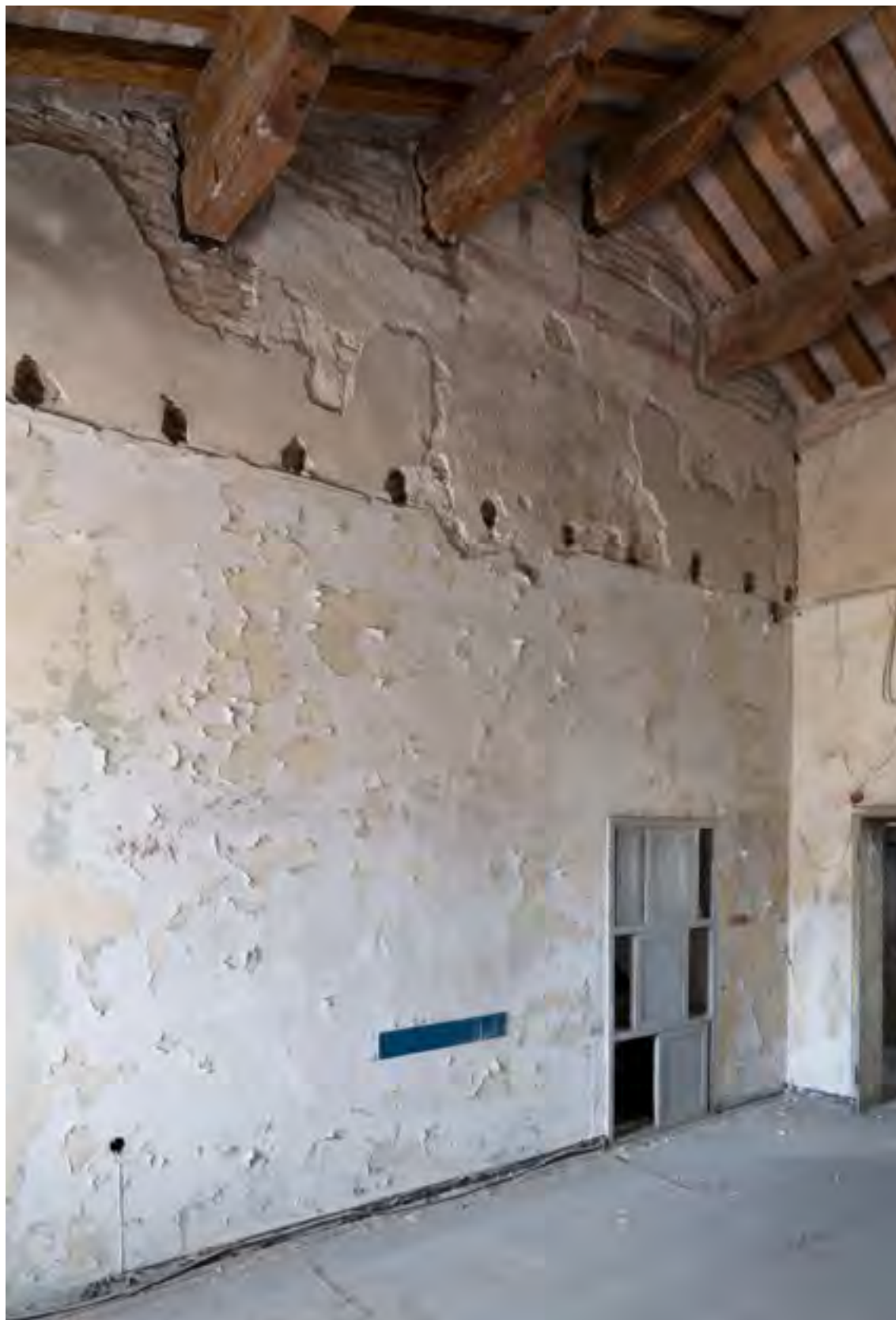
Fig. 109: Padova, castello carrarese, ala orientale, piano secondo, muro di testata meridionale con fasi di modifica delle merlature, dopo il rifacimento delle coperture.
