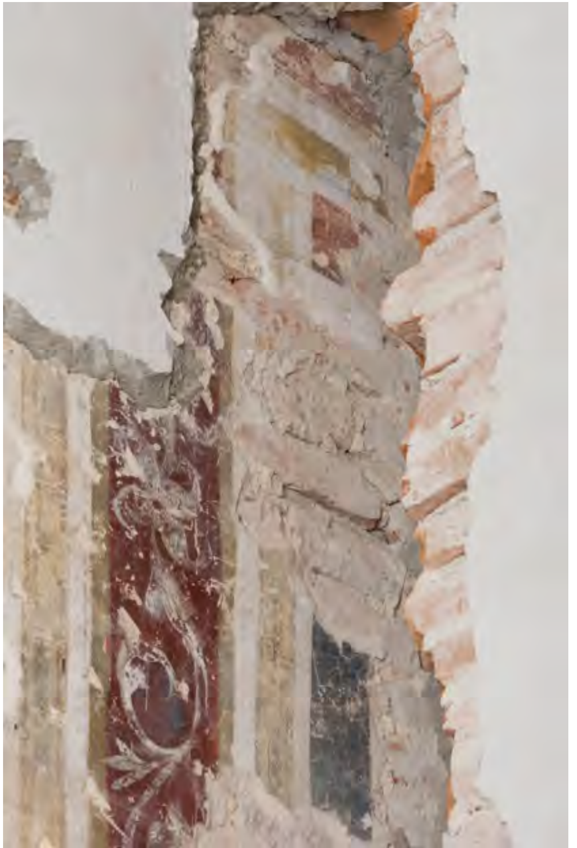
Fig. 99: Padova, castello carrarese, ala orientale, piano primo, Sala a specchiature marmoree , parete settentrionale, particolare.
