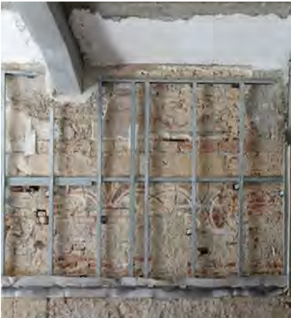
Fig. 21: Padova, castello carrarese, ala settentrionale, piano terra, Sala a maglia di cerchi intrecciati , parete occidentale dopo la messa in sicurezza degli affreschi.
