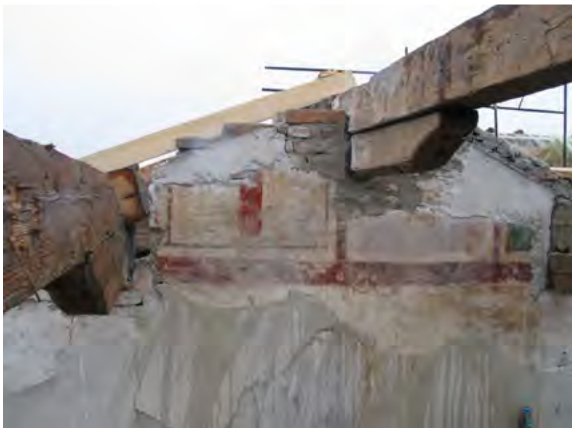
Fig. 108: Padova, castello carrarese, ala orientale, piano secondo, muro di testa meridionale con fasi di modifica delle merlature, in basso le tracce delle archeggiature pensili.
