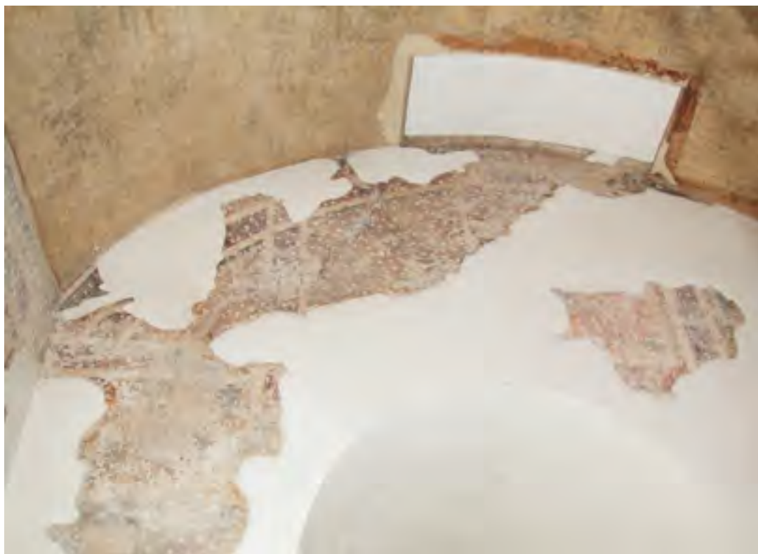
Fig. 158: Padova, castello carrarese, Torlonga, piano primo, Camera delle polveri , parete occidentale, prima del restauro.
