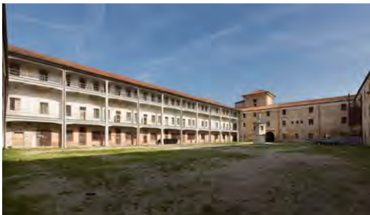
Fig. 5: Padova, castello carrarese, ala settentrionale, esterno.
