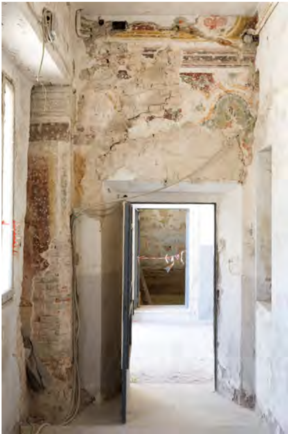
Fig. 83: Padova, castello carrarese, ala orientale, piano terra, loggia, parete settentrionale.
