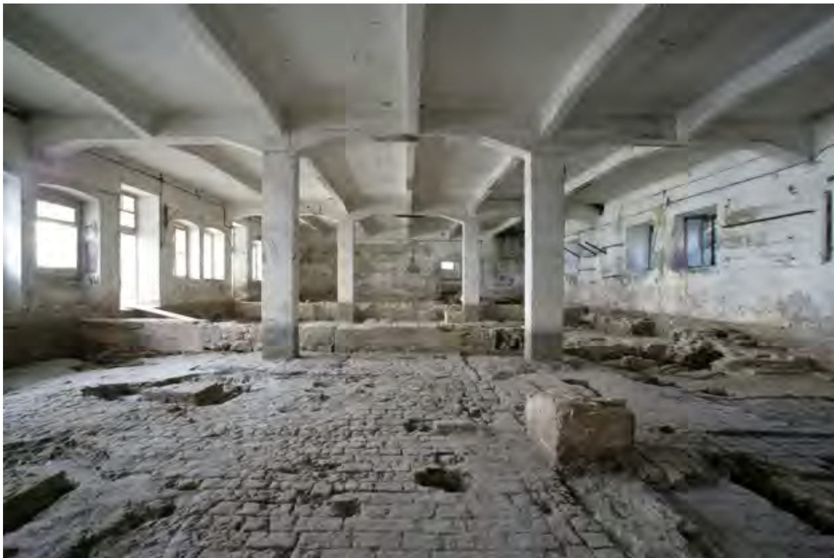
Figg. 46-47: Padova, castello carrarese, ala settentrionale, piano terra, vano 108. Pavimenti in laterizio e spiccati delle suddivisioni carraresi in moduli dopo l'asporto dell'innalzamento ottocentesco.
