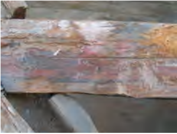
Fig. 96: Padova, castello carrarese, trave oggi non più visibile in quanto confinata negli spazi sottotetto della torre est.
