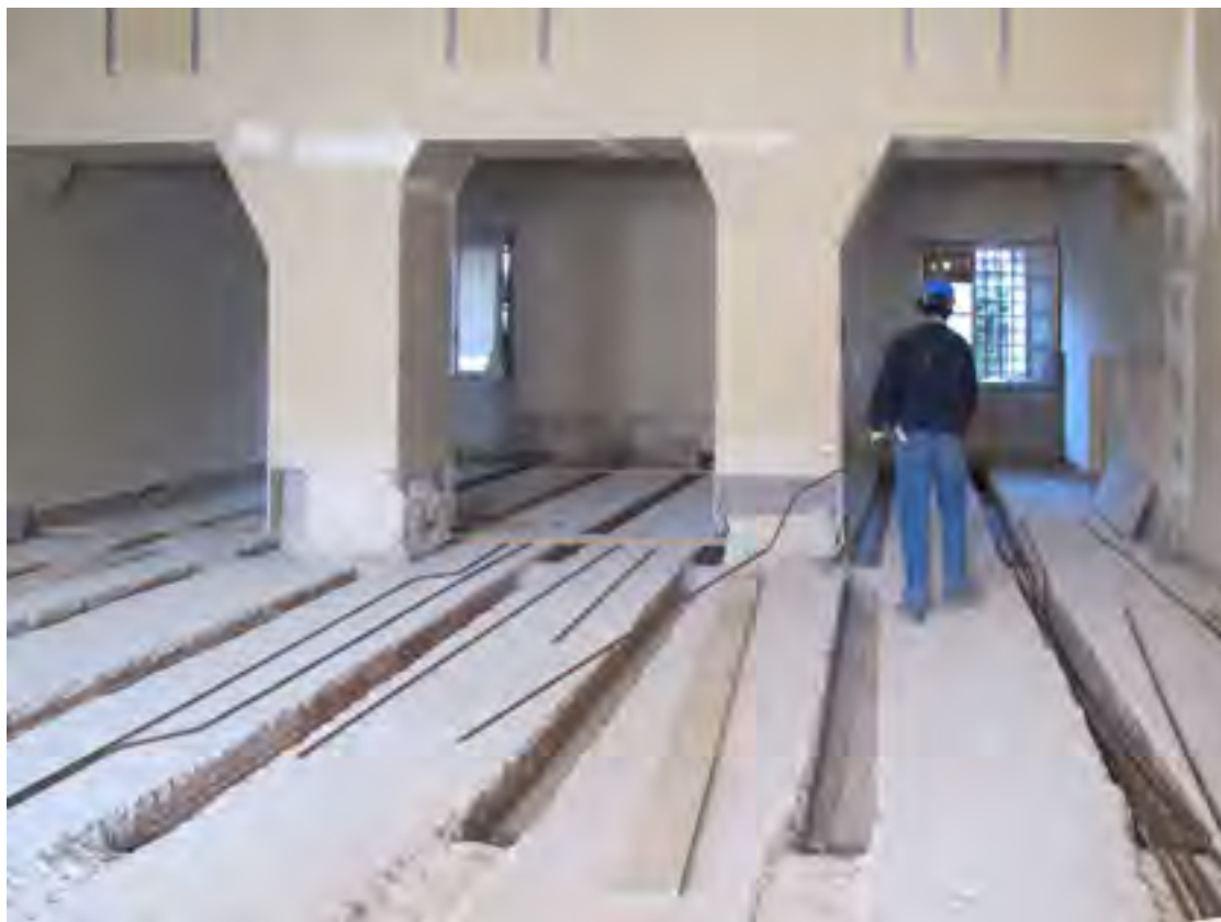
Fig. 60: Padova, castello carrarese, ala settentrionale, piano primo, Sala di Luigi d'Ungheria , protezione delle superfici affrescate durante le fasi di consolidamento dei solai.
