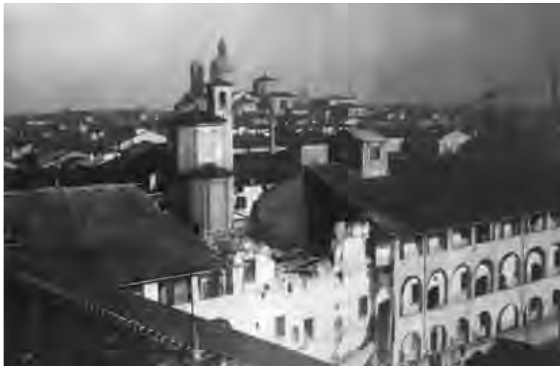
Fig. 167: L'ala settentrionale del castello in seguito al bombardamento austriaco del 5 febbraio 1918.
