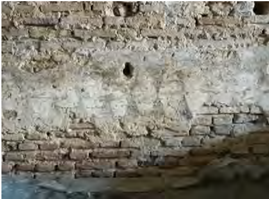
Fig. 34: Padova, castello carrarese, ala settentrionale, piano terra, Sala degli ottoni , particolare della fascia inferiore del vano posteriore.
