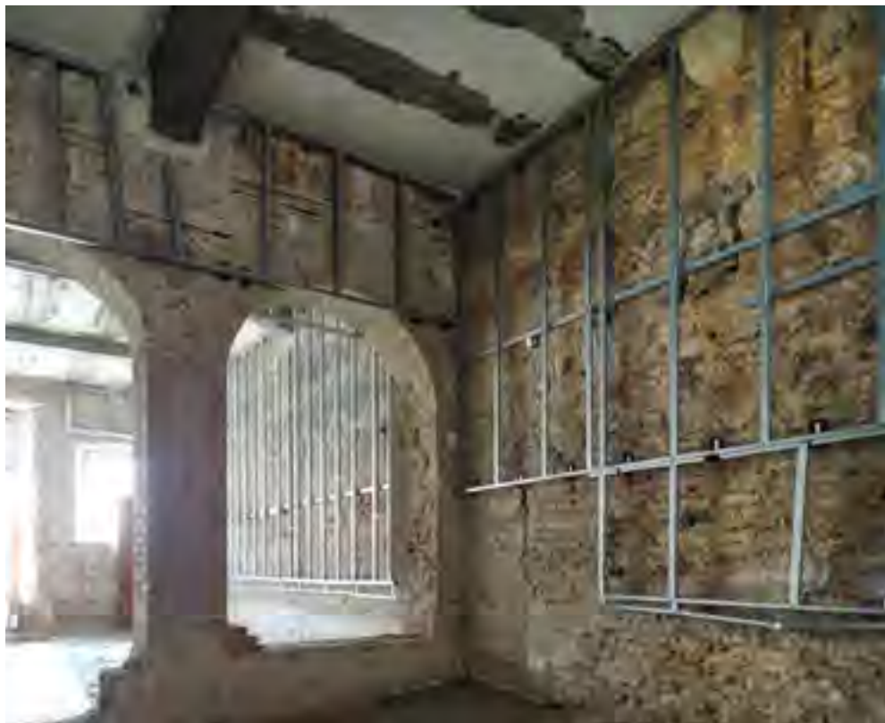
Fig. 22: Padova, castello carrarese, ala settentrionale, piano terra, Sala degli ottagoni , vano posteriore.
