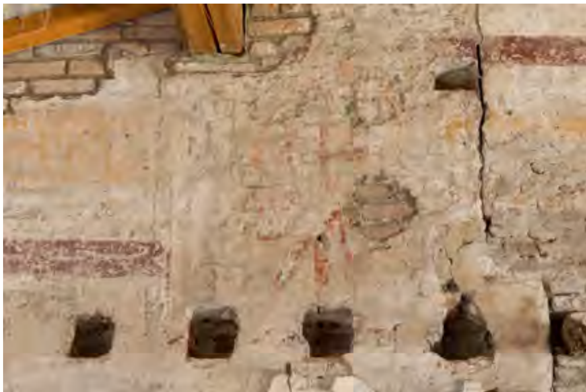
Fig. 107: Padova, castello carrarese, ala orientale, piano secondo, muro meridionale con fasi di modifica delle merlature, tracce del carro carrarese.
