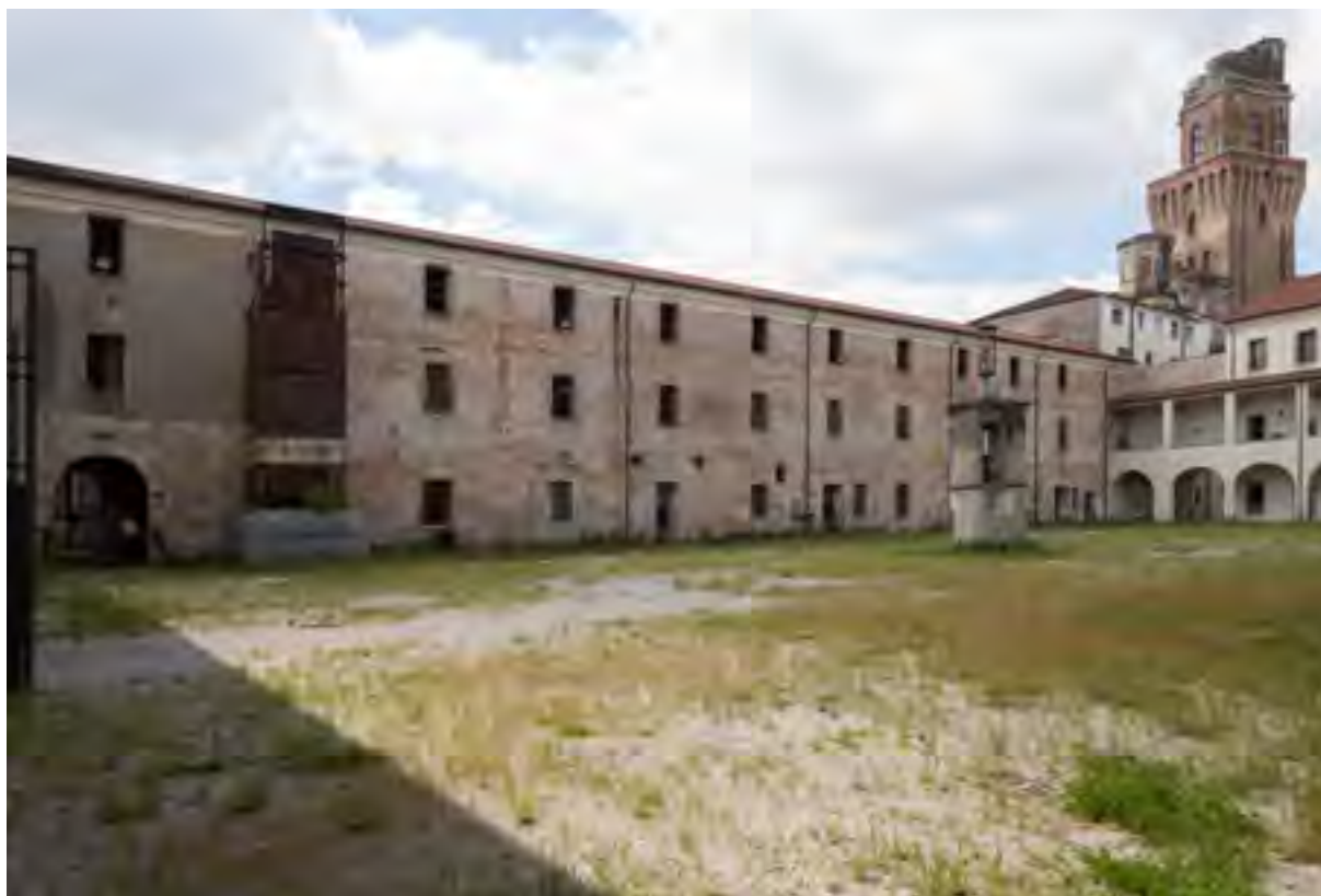
Fig. 3: Padova, castello carrarese, ala meridionale, esterno.
