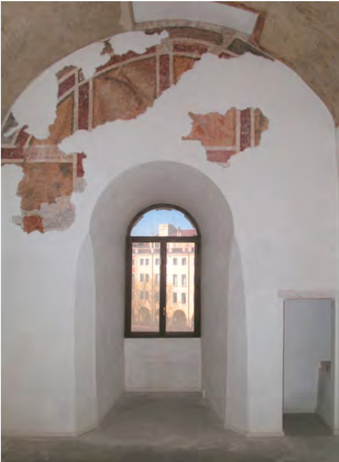
Fig. 159: Padova, castello carrarese, Torlonga, piano primo, Camera delle polveri , parete occidentale.
