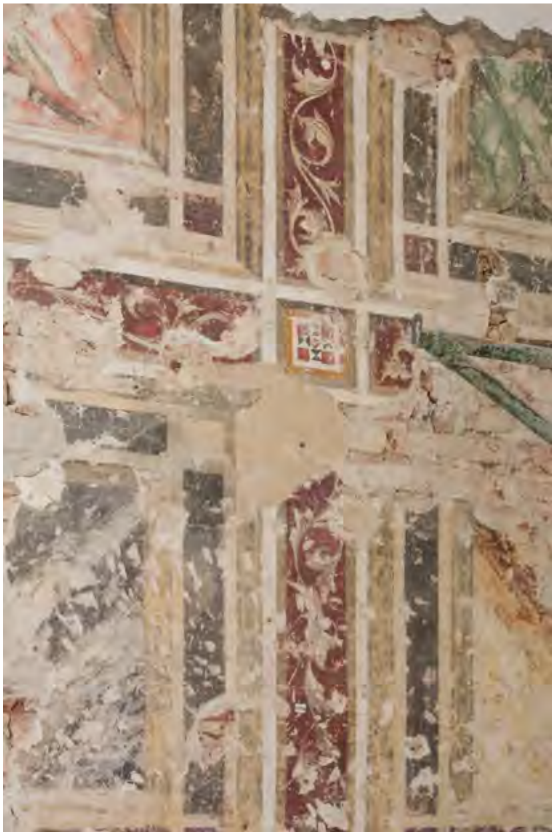
Figg. 102-104: Padova, castello carrarese, ala orientale, piano primo, Sala a specchiature marmoree , parete occidentale, particolari.
