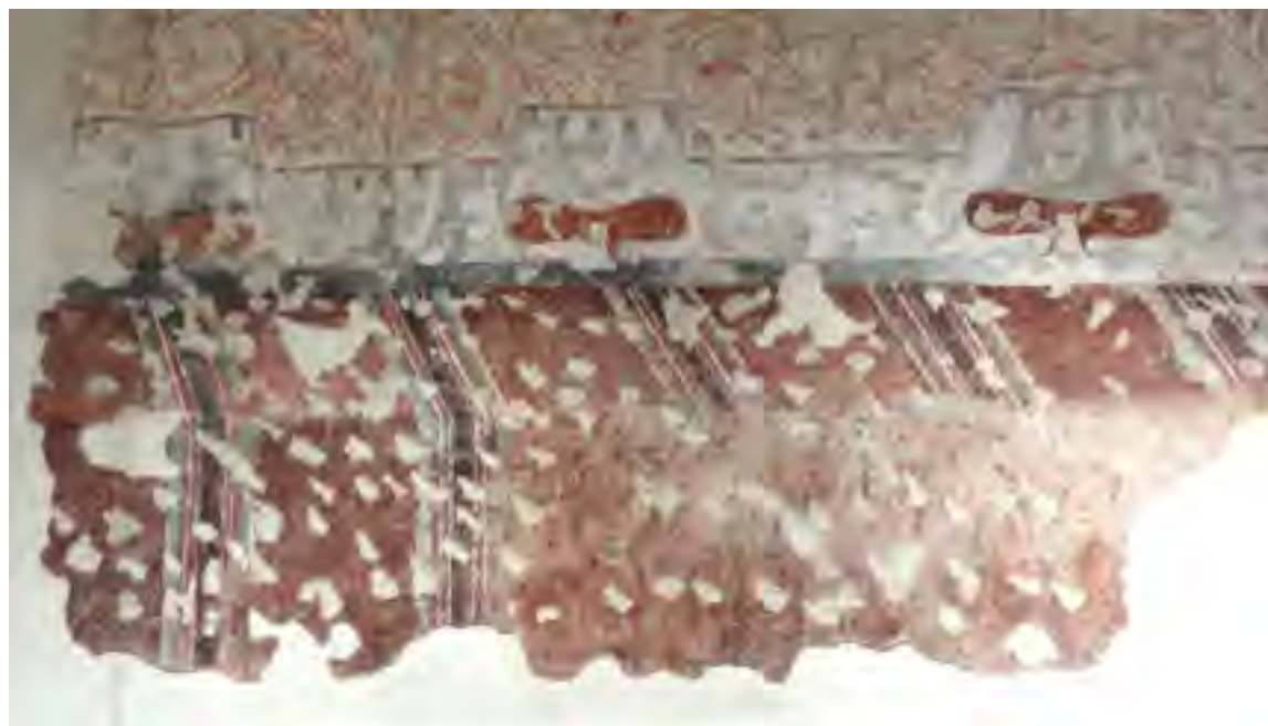
Fig. 149: Padova, castello carrarese, ala meridionale, edificio noto come Casa dell'Astronomo, piano primo, Camera dei pappagalli , parete orientale, particolare.
