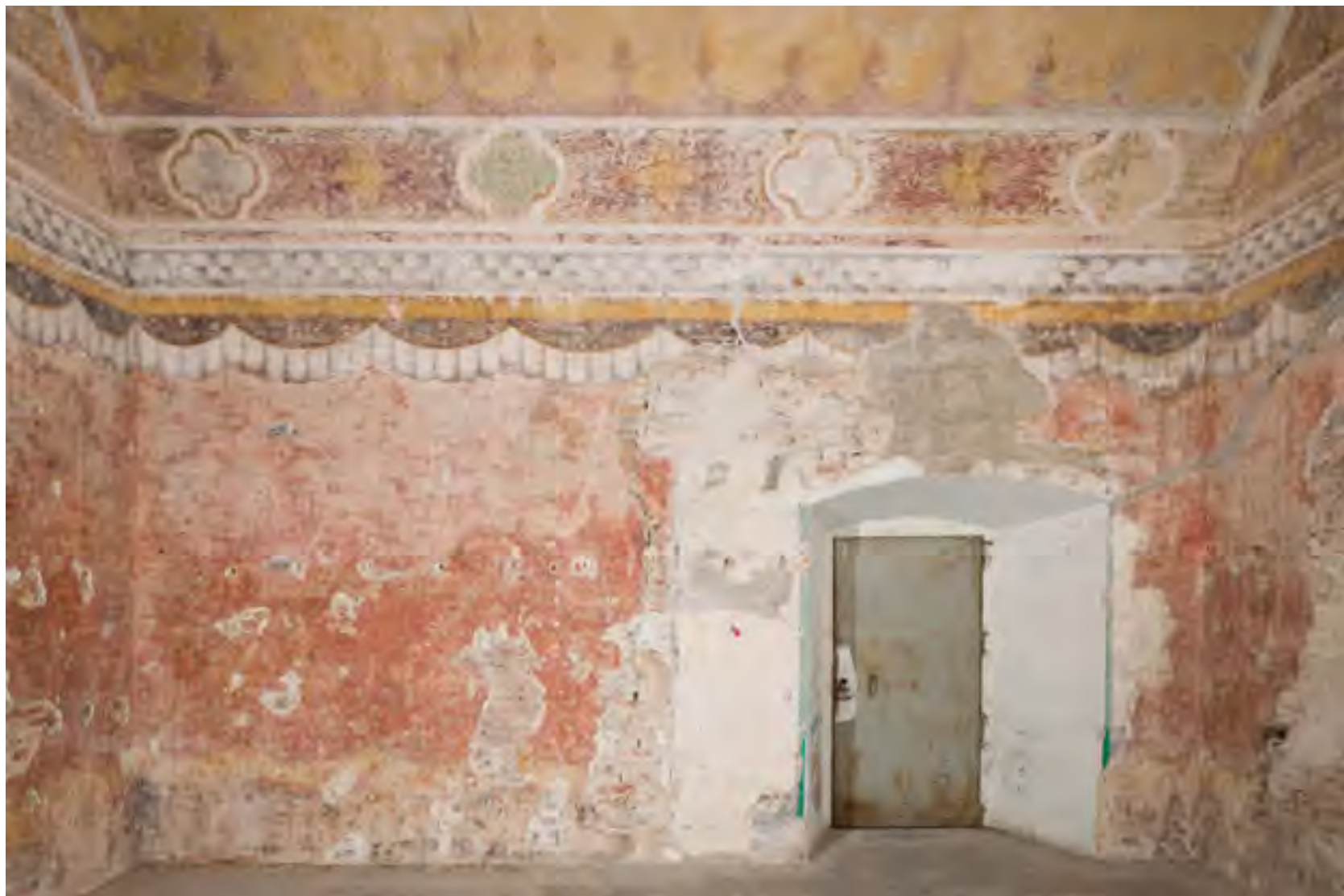
Fig. 117: Padova, castello carrarese, torre orientale, piano primo, Sala del roseto con velario , parete meridionale.
