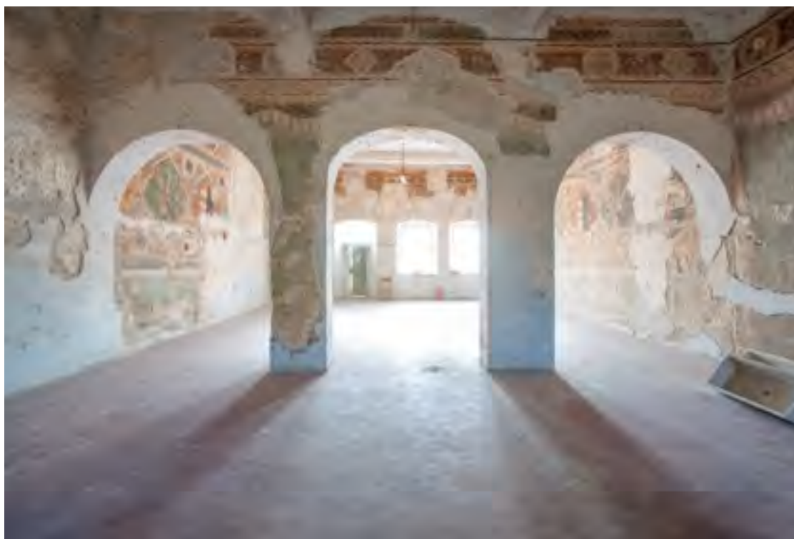
Figg. 61-62: Padova, castello carrarese, ala settentrionale, piano primo, Sala di Luigi d'Ungheria con velario, parete meridionale.
