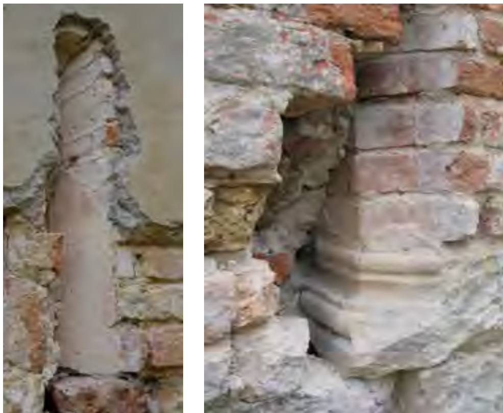
Fig. 16: Padova, castello carrarese, ala orientale, piano terra, terzo pilastro della loggia con lacerto di “regalzier”.
