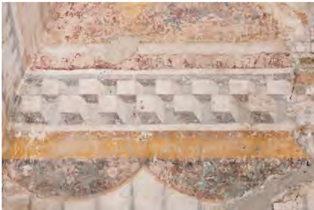
Fig. 130: Padova, castello carrarese, torre orientale, piano primo, Sala del roseto con velario , particolare della fascia a parallelepipedi sfalsati.
