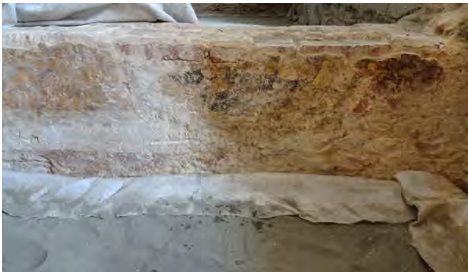
Fig. 50: Padova, castello carrarese, ala settentrionale, piano terra, Sala con decorazione geometrica a oculi (vano 108), parete orientale.
