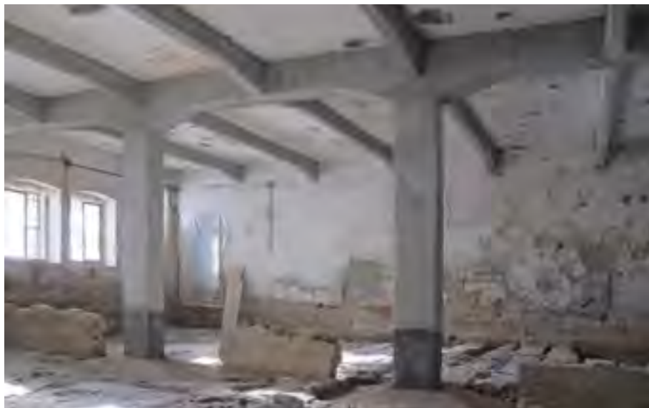
Fig. 39: Padova, castello carrarese, ala settentrionale, piano terra, Sala del velario a pelte (vano 109). Strutture in calcestruzzo dopo il consolidamento e resti della muratura di suddivisione eretta in una fase postcarrarese.
