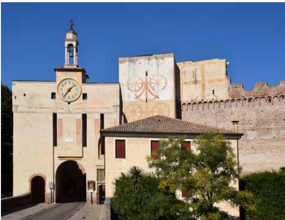
Porta Padova e Torre di Malta da sud.
