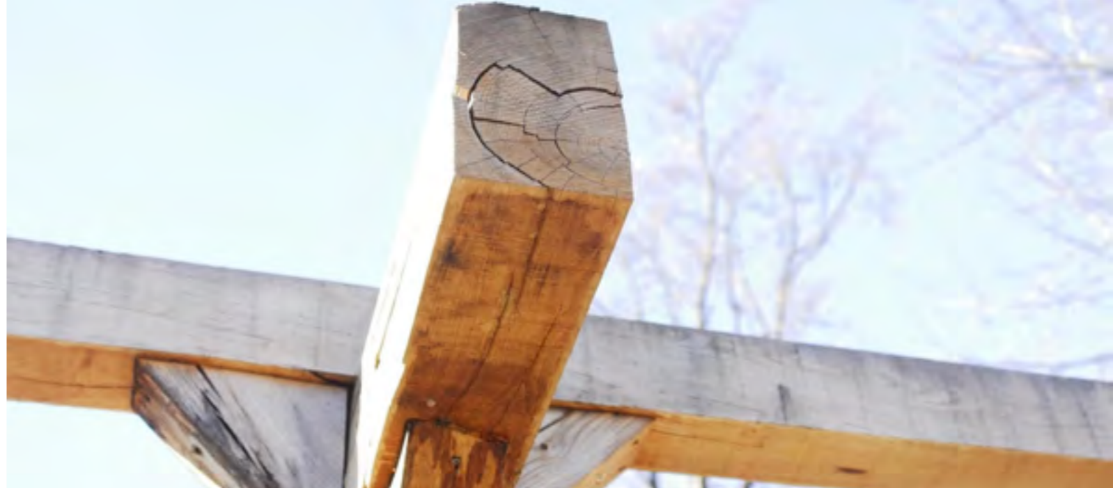
Figura 2. Cipollatura multipla su trave in opera.
