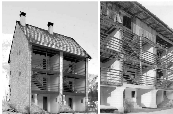
Fig. 4-5 - Il tipo “a ballatoio su setti” tipico di Andreis in un edificio isolato e all’interno di una schiera - Fonte: foto di F. Chinellato.
