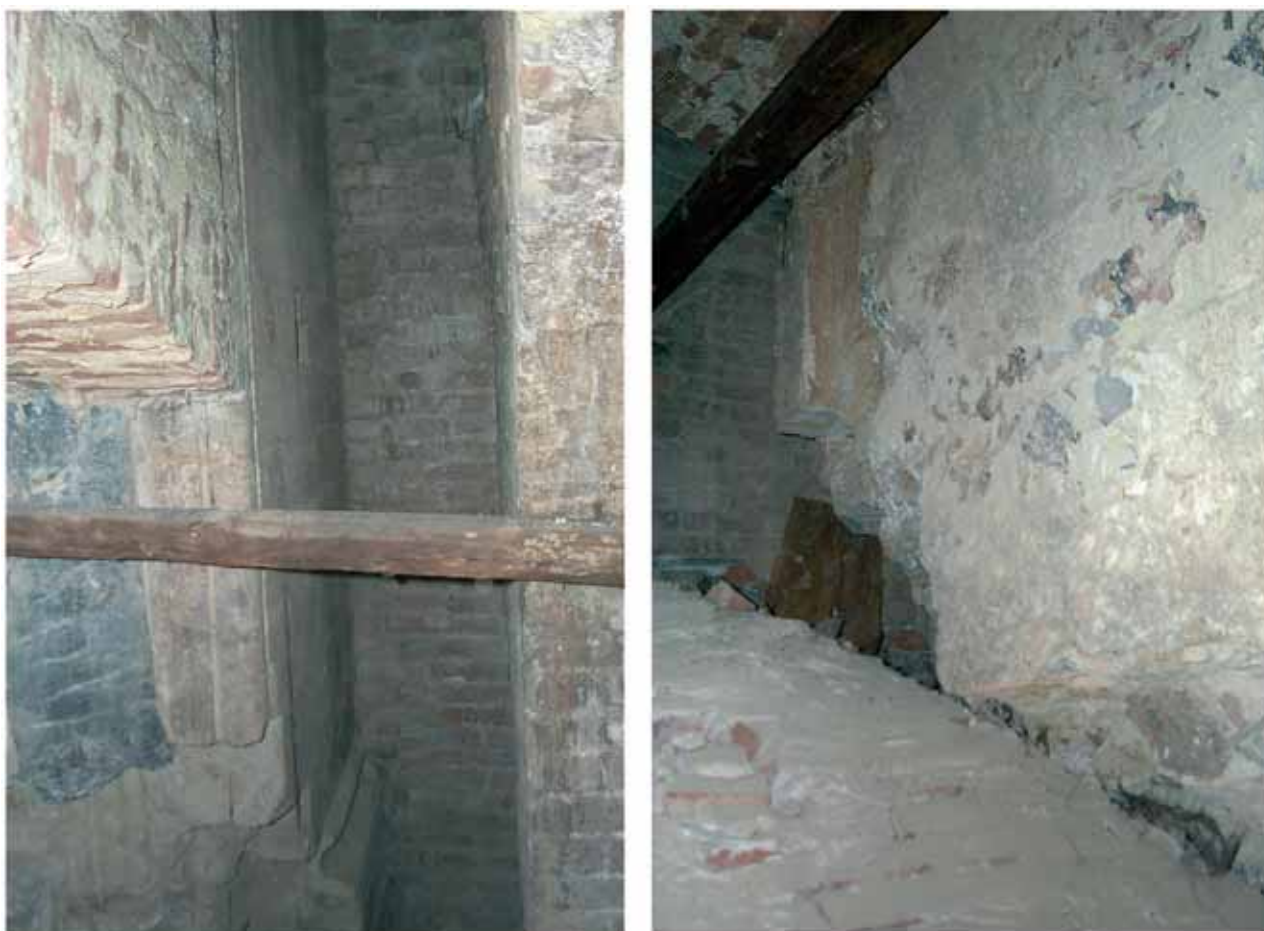
Fig. 16. Particolari della facciata orientale della cattedrale: a sinistra, particolare del paramento murario esterno della facciata e dello stipite destro del portale centrale; a destra, particolare dello stipite sinistro del portale centrale, tagliato dall'abside del Battistero
