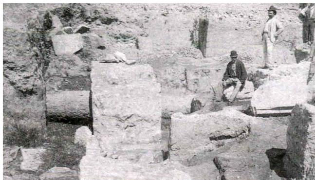
Fig. 95 – Padova, scavo dell'anfiteatro, 1880 (MI 491). Si osserva come il condotto in tubi di trachite risulti interrotto dal perimetro dell'edificio di spettacolo (TOLOMEI 1981, p. 31).
