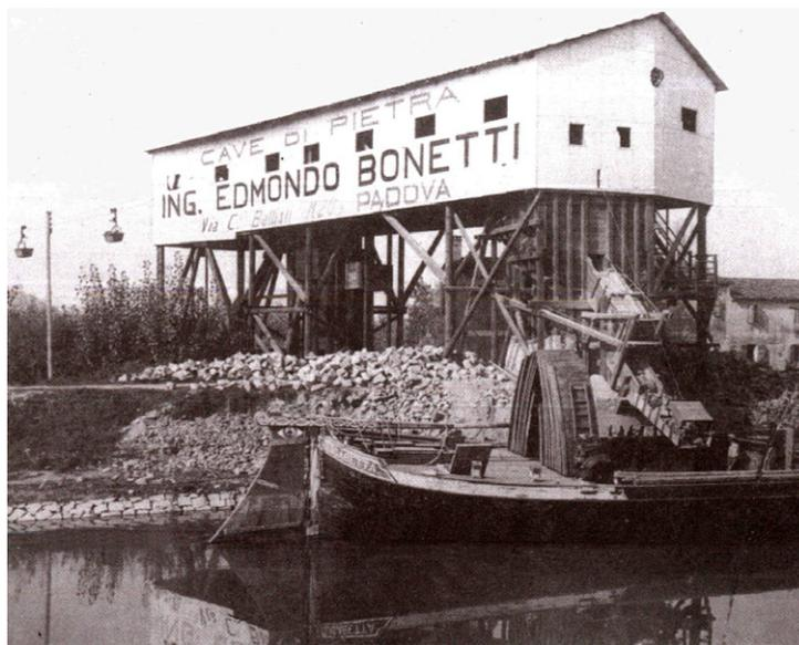
Fig. 276 – Stazione d'arrivo della teleferica per il trasporto della trachite tra Monte Oliveto e l'approdo di Mezzavia, anni Trenta del Novecento (da GRANDIS 1997, p. 39).
