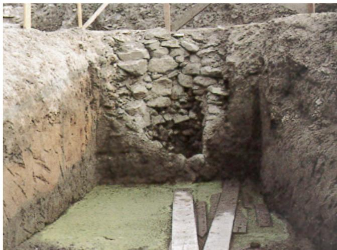
Fig. 126 – Este (PD), via Settabile, ospedale civile (MI 907). Canna di un pozzo in ciottoli trachitici (BAGGIO BERNARDONI 1992, fig. 230b, p. 217).
