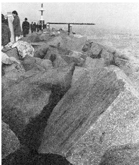
Fig. 13 – Porto Garibaldi di Comacchio (FE), coronamento del molo sud in blocchi di trachite di Monte Merlo (CALVINO 1969, p. 26, fig. 4).
