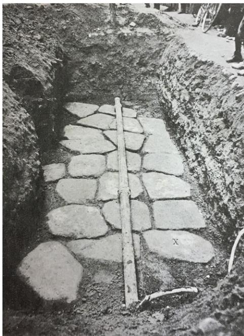
Fig. 225 – Ferrara, via Garibaldi 94-139 (MI 397). Pavimentazione stradale in basoli trachitici (BORGATTI 1912, tav. I).
