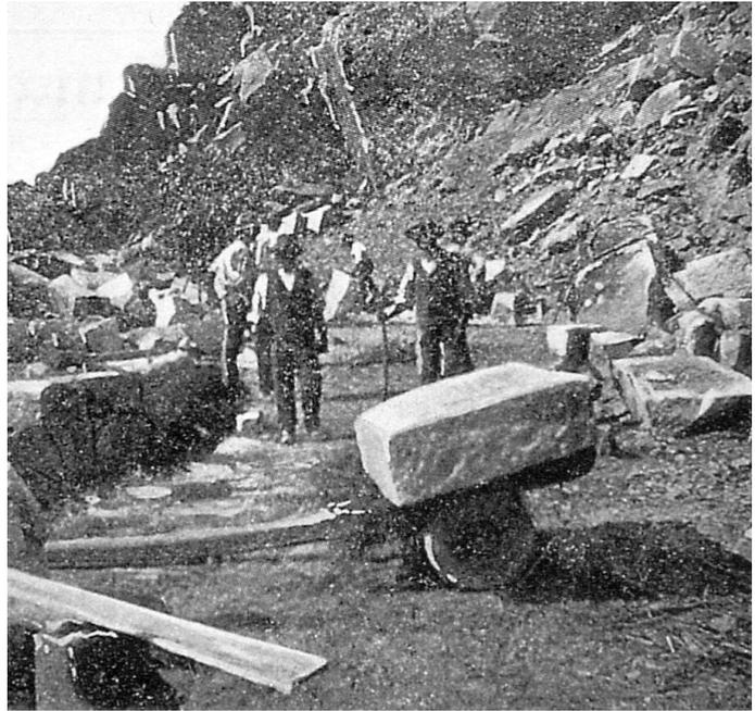
Fig. 273 – Montegrotto Terme, 1903. Attività presso le cave di San Pietro Montagnon; in primo piano un blocco di medie dimensioni spostato all'interno della cava mediante un carro a due ruote (GRANDIS 1997, p. 35).
