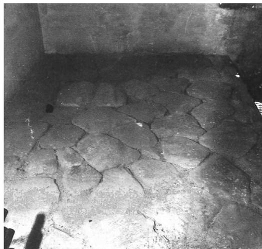
Fig. 213 – Mantova (MN), via Broletto (MI 612). Pavimentazione stradale in basoli trachitici (TAMASSIA 1984, fig. 114, p. 119).
