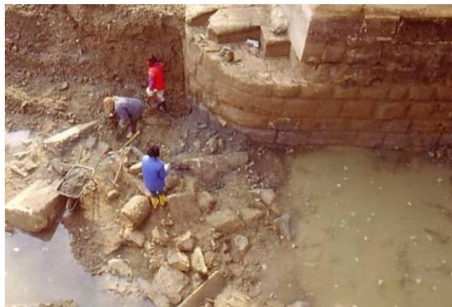
Fig. 311 – Rimini (RN), ponte di Tiberio (MI 1329). In alto a destra, pila con platea di fondazione in blocchi trachitici bugnati, 14-21 d.C. (RIMONDINI 2014, p. 13).
