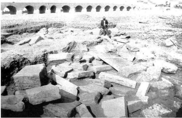
Fig. 247 – Bologna (BO), cd. muro del Reno, struttura idraulica tardo antica costituita da blocchi di reimpiego, tra cui monumenti funerari in trachite (BRIZZOLARA 2005, fig. 3, p. 519).
