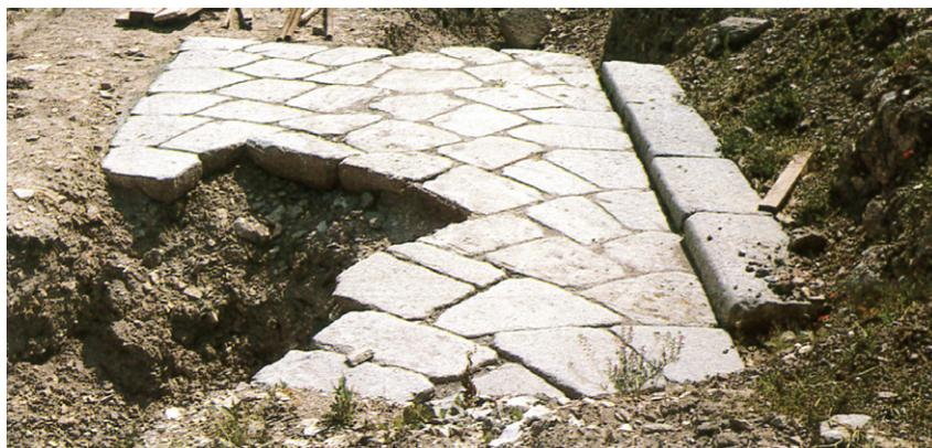
Fig. 129 – Este (PD), via Settabile, ospedale civile, saggio 1978-1980 (MI 380-381). Pavimentazione e cordolo in trachite di tratto stradale che serviva le abitazioni scavate in quest'area urbana, inizio età augustea (BAGGIO BERNARDONI 1987, p. 224).
