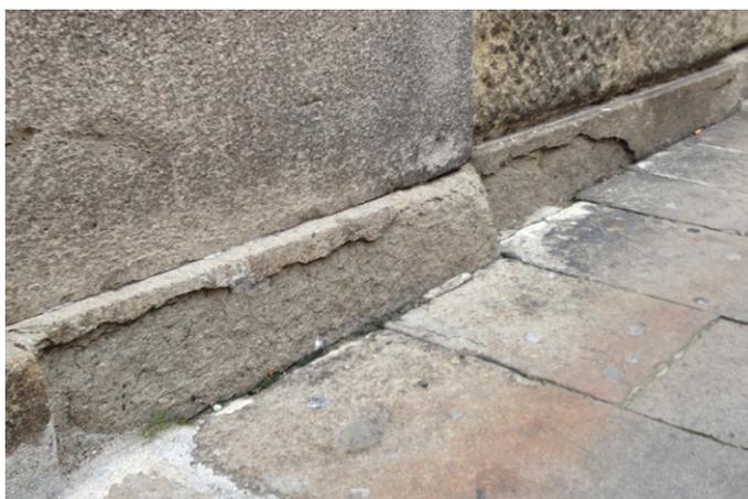
Fig. 19 – Padova, via Santa Lucia. Zoccolo di edificio in trachite soggetto a degrado (foto autore, febbraio 2015).
