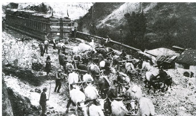
Fig. 271 – L'obelisco monolitico destinato al Foro Italico trasportato dalle cave di Carrara su slitte trainate da buoi (ADAM 2008, fig. 32, p. 30).
