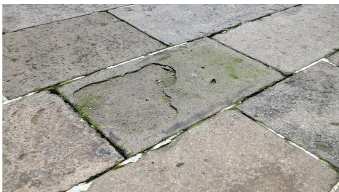
Fig. 18 – Padova, piazza Insurrezione. Lastra in trachite soggetta a degradazione centrale (foto autore, febbraio 2015).
