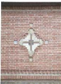
Particolare decorativo sulla facciata della chiesa realizzato utilizzando pezzi di mattoni di diverse coloriture e mattoni faccia a vista.
