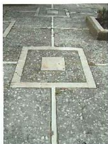
Particolare della pavimentazione pedonale.
