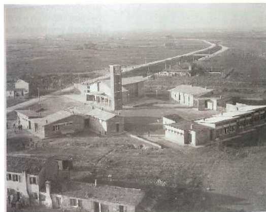
Vista della borgata di servizio di Cà Mello a lavori ultimati. In primo piano un vecchio edificio che rappresentava il centro di vita preesistente.
