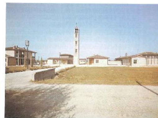
Un'immagine della borgata di servizio di Cava appena completata i lavori.
