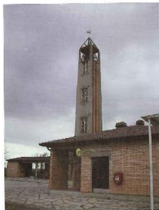
La semplicità compositiva di uno degli edifici del centro sociale. L'attenzione ai particolari nella immagine un esempio architettonico di un certo pregio.
