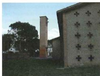
Vista del campanile da dietro la chiesa, è possibile notare la complessa articolazione degli spazi.
