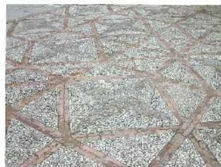
Particolare della pavimentazione pedonale.
