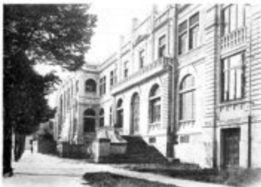
Fig. 7. L'edificio degli Istituti Anatomici e della Medicina Legale in una foto del 1971. Il grandioso complesso occupa un'area totale di 8340 m 2 e un'area coperta di 3980 m 2 .
