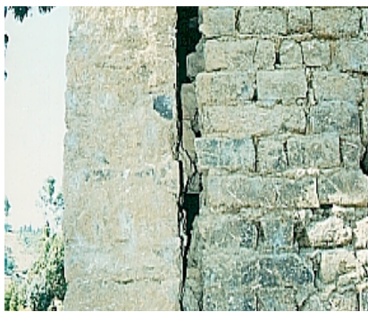
Figura 17. Detalle de la separación de muros ortogonales.
