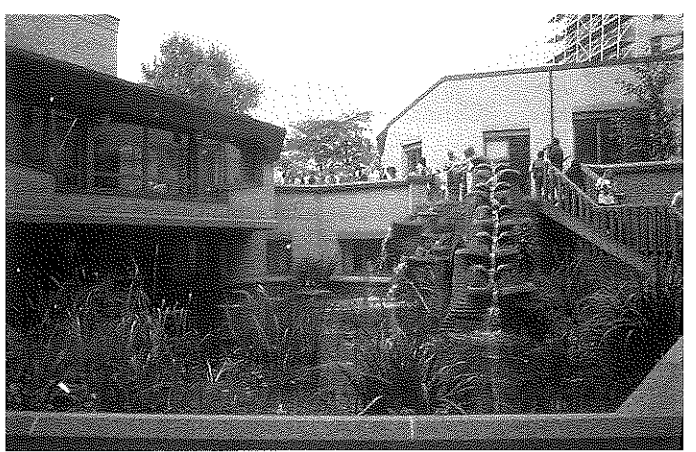
FOTO 14 Amsterdam; Sede centrale della NMB Bank - Gli spazi scoperti esterni con il bacino di raccolta delle acque bianche con l'utilizzo delle «flowforms», sull'esempio delle «vasche vive» ideate da J. Wilkes.
