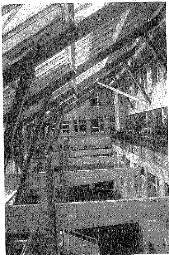
FOTO 16 Francoforte; Ökohaus di Westbahnhof - Vista interna della grande serra addossata alla parete sud dell'edificio, in qualità di «cuscinetto acustico» dai rumori esterni e come sistema passivo di captazione della radiazione solare.
