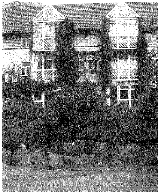
FOTO 1 Tubinga; Villaggio Shafbrühl — Vista interna del villaggio con particolare delle terrazze-verande utilizzate in qualità di sistemi passivi di captazione solare. Si evidenzia l'uso sapiente ed articolato degli spazi e dei percorsi interni, interamente pedonali. Il villaggio, composto di 9 edifici, consta di 111 alloggi e qualche negozio, su un'area complessiva di circa 13.000 mq.
