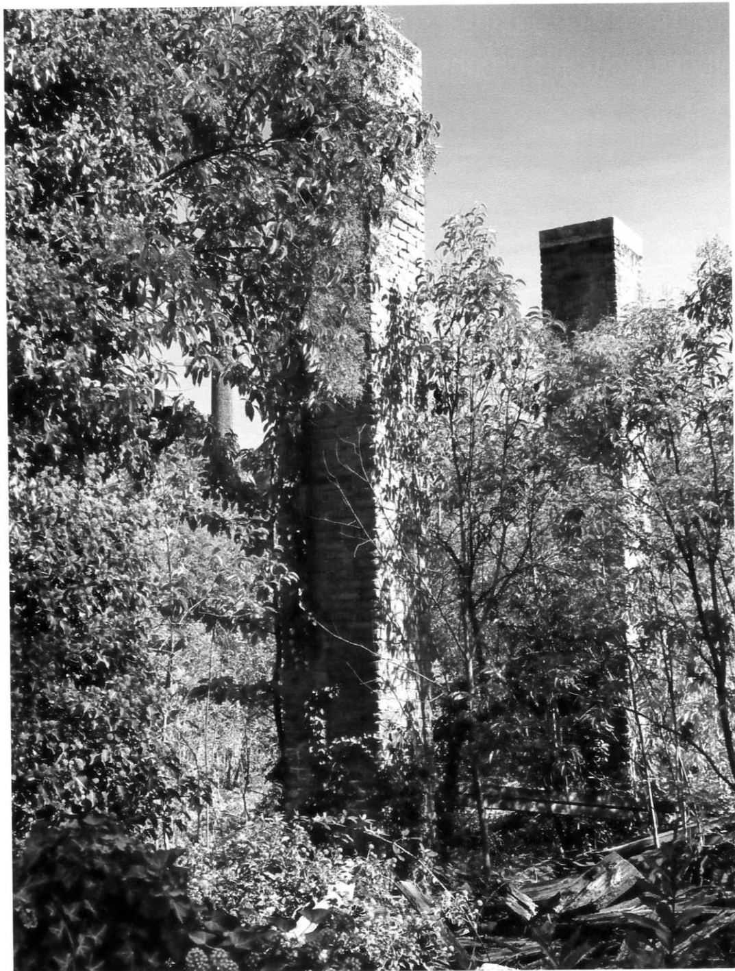
Fabbricato dell'ex Complesso Montecatini disposto con orientamento nord-sud, particolare dei pilastri nella porzione ridotta a rovina.
