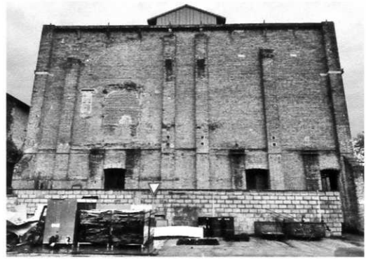
Ex Officine Boranga, facciata rivolta ad ovest del fabbricato principale.
