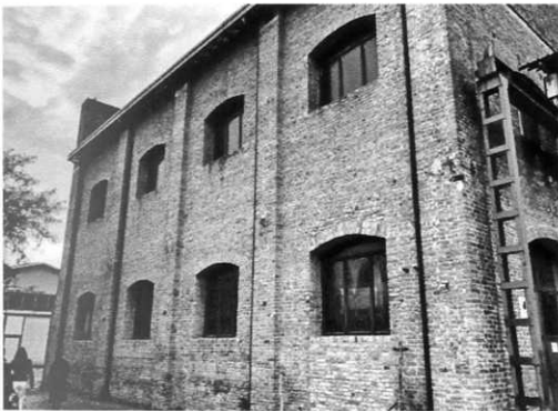
Ex Officine Boranga, facciata sud verso via Zecchin del fabbricato principale.
