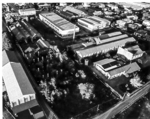
Veduta aerea dell'area dell'ex Complesso Montecatini e delle ex Officine Boranga.
