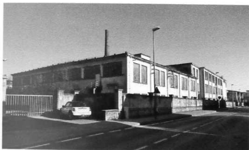
Ex Filatura Monti, veduta del fronte su via Risorgimento - a destra - e di quello sullo scoperto interno. Stato attuale.
