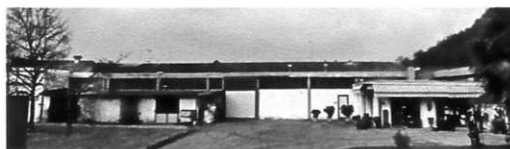
Complesso Celato, veduta da via Erizzo, stato attuale.
