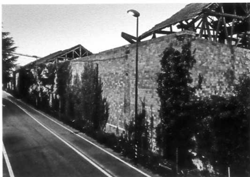
Ex Complesso Montecatini, veduta del fronte su via Zecchinel con andamento nord-sud (dall'elaborato di Francesca Benedetto, Beatrice Di Rosa, Paolo Meneghetti, Lorenzo Tavano). La direttrice corrisponde ad un ramo della ferrovia cui i volumi erano accostati con pavimentazione rialzata per le operazioni di carico.
