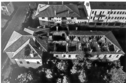
Ex Complesso Montecatini, particolare della palazzina che fungeva da ingresso e sede dell'Amministrazione. A sinistra nella foto via Zecchinell presso l'incrocio con via Piave.
