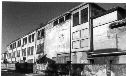
Ex Filatura Monti, veduta da sud del fronte su via Risorgimento. Stato attuale.
