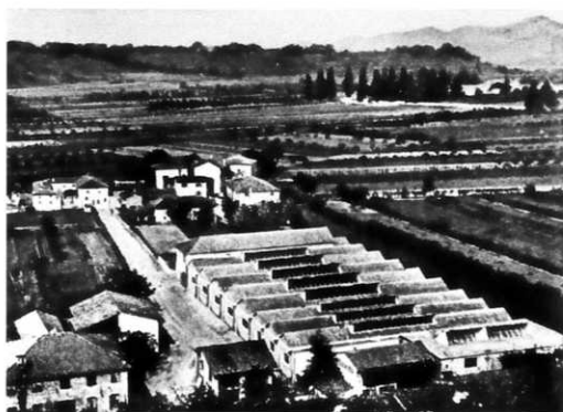
Vista della Filatura Gioppo dal Montello in una foto risalente agli anni tra il 1940 e il 1950 (Biblioteca comunale di Montebelluna). A sinistra si riconosce via dei Celato.
