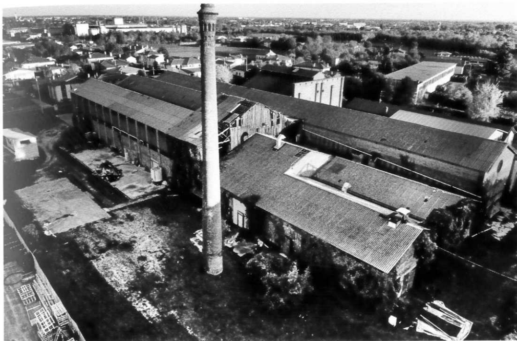
Ex Complesso Montecatini, veduta dei fabbricati disposti ortogonalmente a via Zecchin, con accesso diretto da via Gazie.
