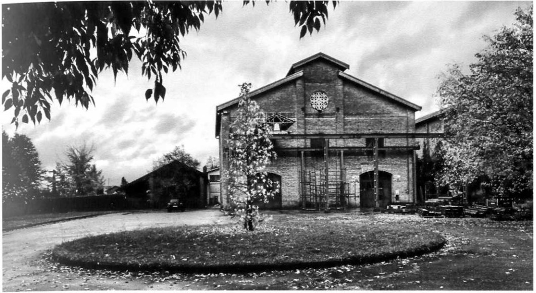
Ex Officine Boranga, veduta da via Gazine della facciata est del fabbricato principale (dall'elaborato di Lara Bianchin, Giulia Bortolotto, Caterina Miolo, Diletta Romagnolo).
