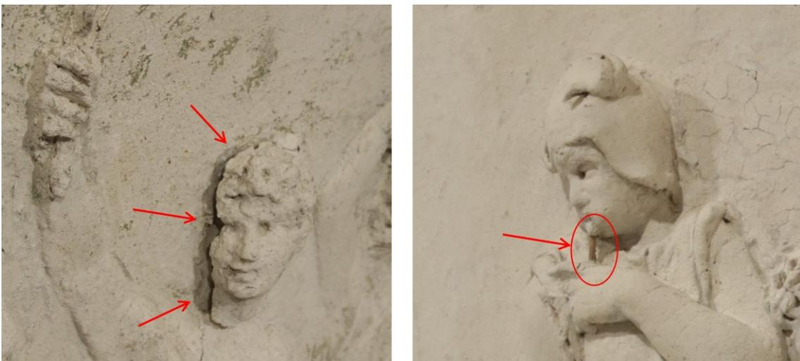
**Figura 5.17.** Immagini di dettaglio della decoesione dal supporto della testa di una figura, nel fregio della parete sud (sinistra), e una canna di legno affiorante per distacco dello stucco, sul fregio della parete nord (destra).
