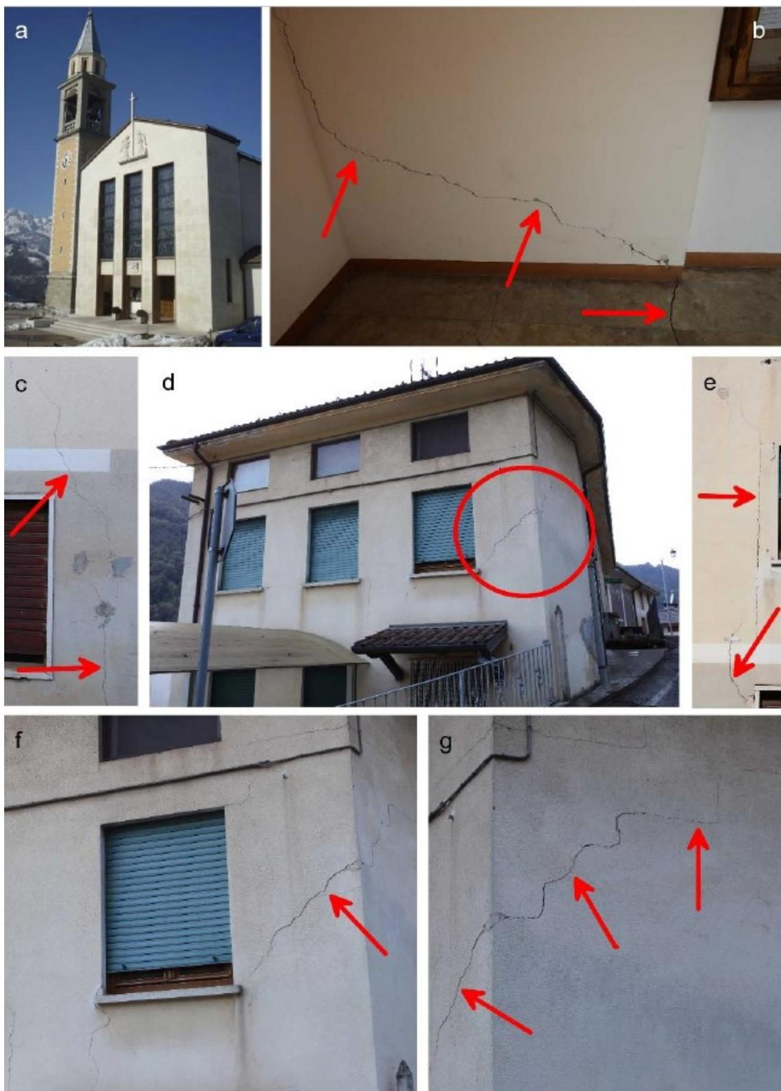
**Figura 3.4.** Immagini della chiesa di Roveglina (a) e della grande fessura sotto il portico di ingresso (b); immagini di uno degli edifici più danneggiati nella contrada Cappellazzi (c–g).
