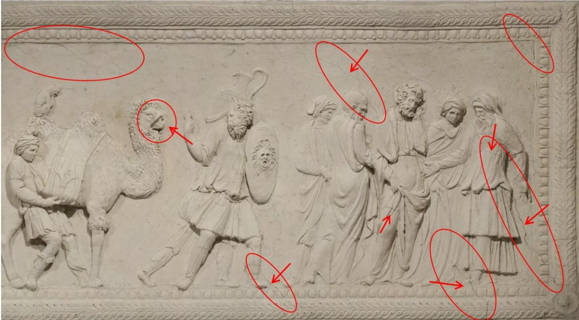
**Figura 5.18.** Dettaglio dell'ortofoto del fregio della parete ovest: si notano le diffuse fessurazioni di varia entità e il distacco dello stucco in corrispondenza del muso del cammello.
