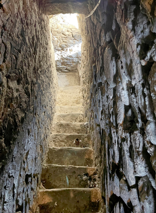
Fig. 9. Omegna (Verbano Cusio Ossola). Interno della torre campanaria della chiesa di Sant'Ambrogio, dettaglio risolto angolare della scala intra muros e vista dall'ultimo registro di trifore [fotografie dell'autrice, febbraio 2019].
