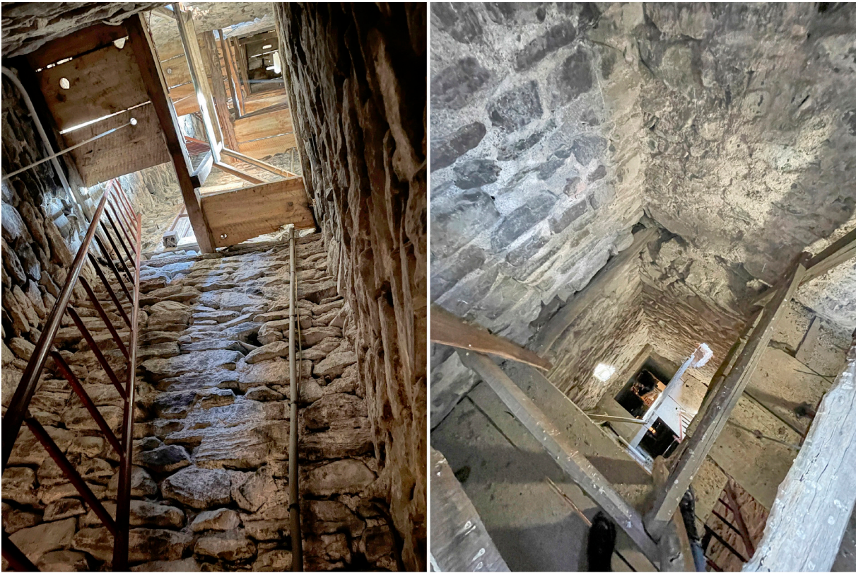
Fig. 1. Agrano (Omegna, Verbano Cusio Ossola). Interno della torre campanaria della chiesa di San Maiolo e dettaglio rincassi della muratura su cui poggiano le travi di bordo degli orizzontamenti lignei [fotografie dell'autrice, febbraio 2019].
