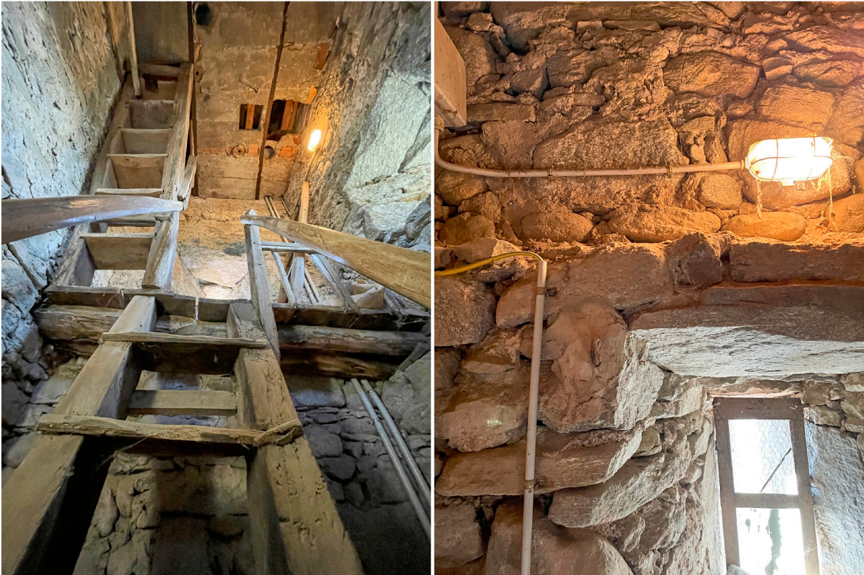
Fig. 4. Oleggio Castello (Novara). Interno della torre campanaria della chiesa di San Martino e dettaglio rincassi della muratura su cui poggiavano le travi di bordo degli orizzontamenti lignei intercettando alcune aperture [fotografie dell'autrice, febbraio 2019].
