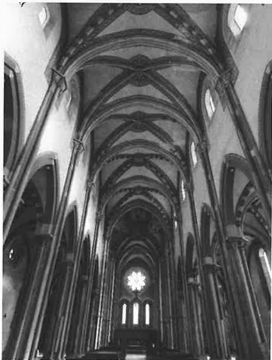
Fig. 1: Chiesa di Sant'Andrea, navata centrale con il sistema dei sostegni e delle coperture voltate
