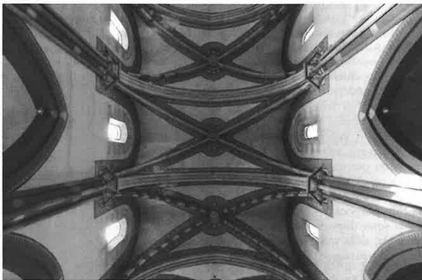
Fig. 2: Chiesa di Sant'Andrea, navata centrale, ritmo discontinuo nell'impiego di conci lapidei e laterizi nei costoloni delle volte
