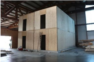
Figura 3 – Mockup realizzato ai fini di studi per il comportamento sismico e acustico, con la stessa tipologia costruttiva del progetto UNIZEB.
