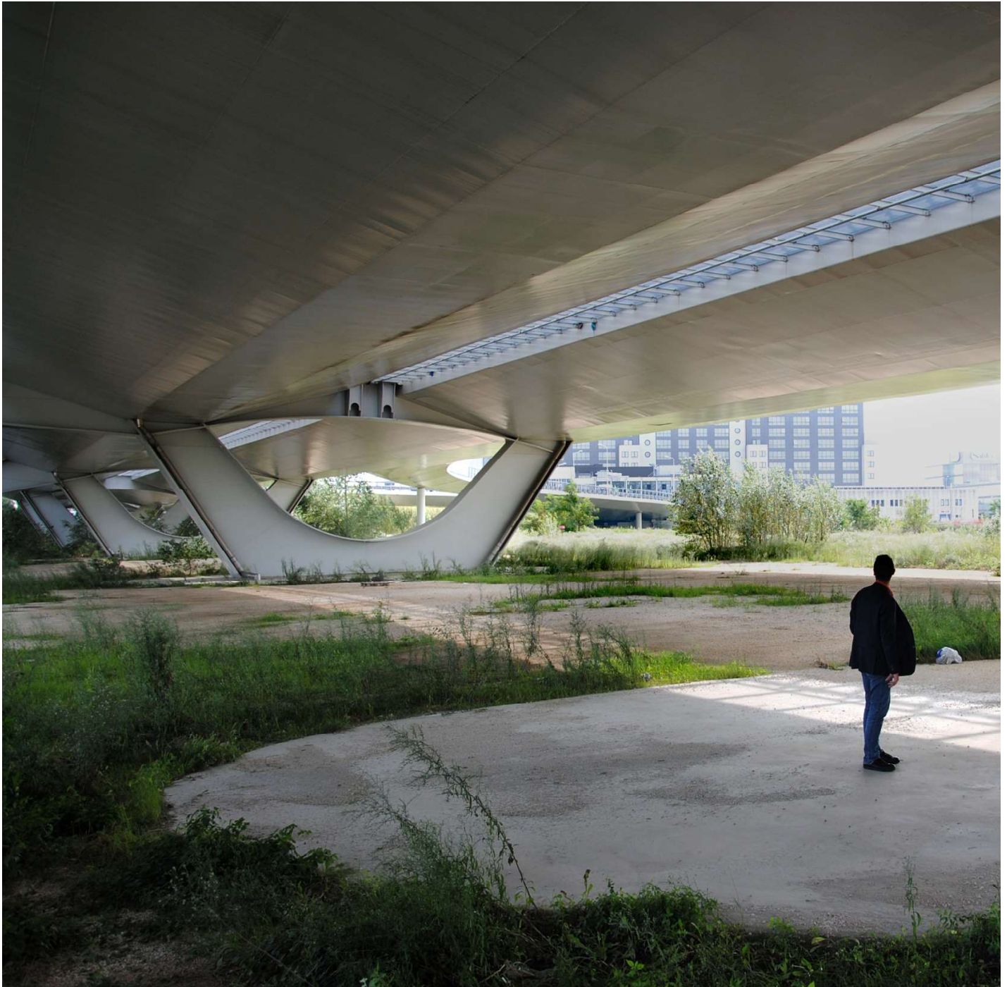
1 - Viadotto Darwin, Padova (2017).
