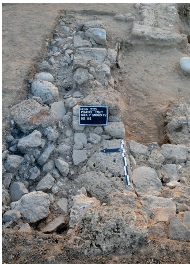
Fig. 6. Nora, Area PV, Saggio 1. Il muro US 145 visto da ovest. A nord del muro sono visibili i livelli di crollo contenenti materiali di età romana.
