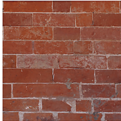
Muratura tipo 2: fase IA medievale con ripristini Prima metà XIII secolo: post 1219 - ante 1230 Corpo longitudinale nord (chostro)
