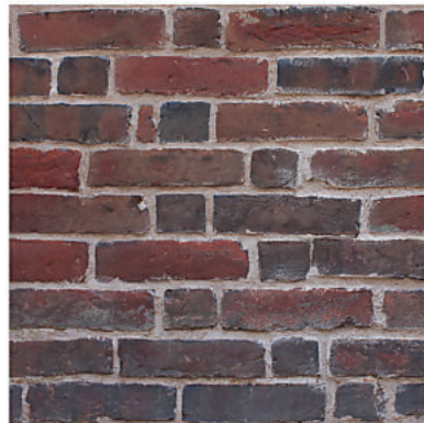
Muratura di ripristino, tipo 8: fase di restauro Attribuzione incerta (XX secolo ?) Basamento torre campanaria
