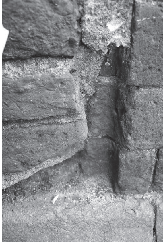
Fig.11. Dettaglio muratura medievale con particolare della base di uno stipite in prossimità dell'apertura tamponata.
