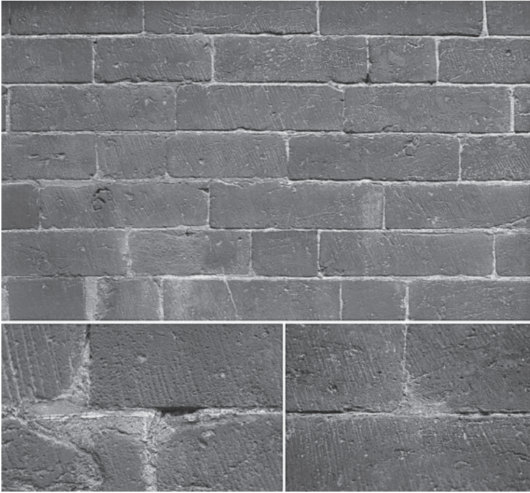
Fig. 3. Dettagli muratura. Perimetrale sud, terza campata.
