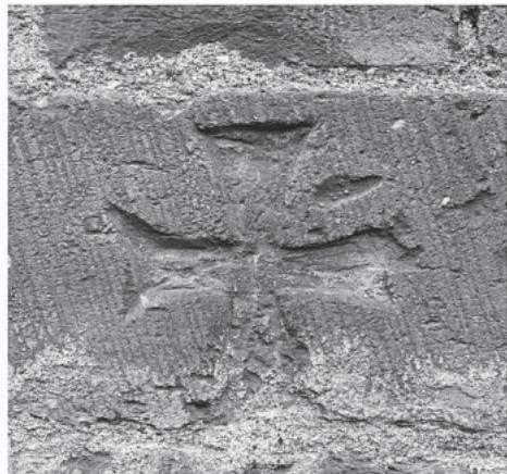
Braccio sud del transetto, fronte sud
