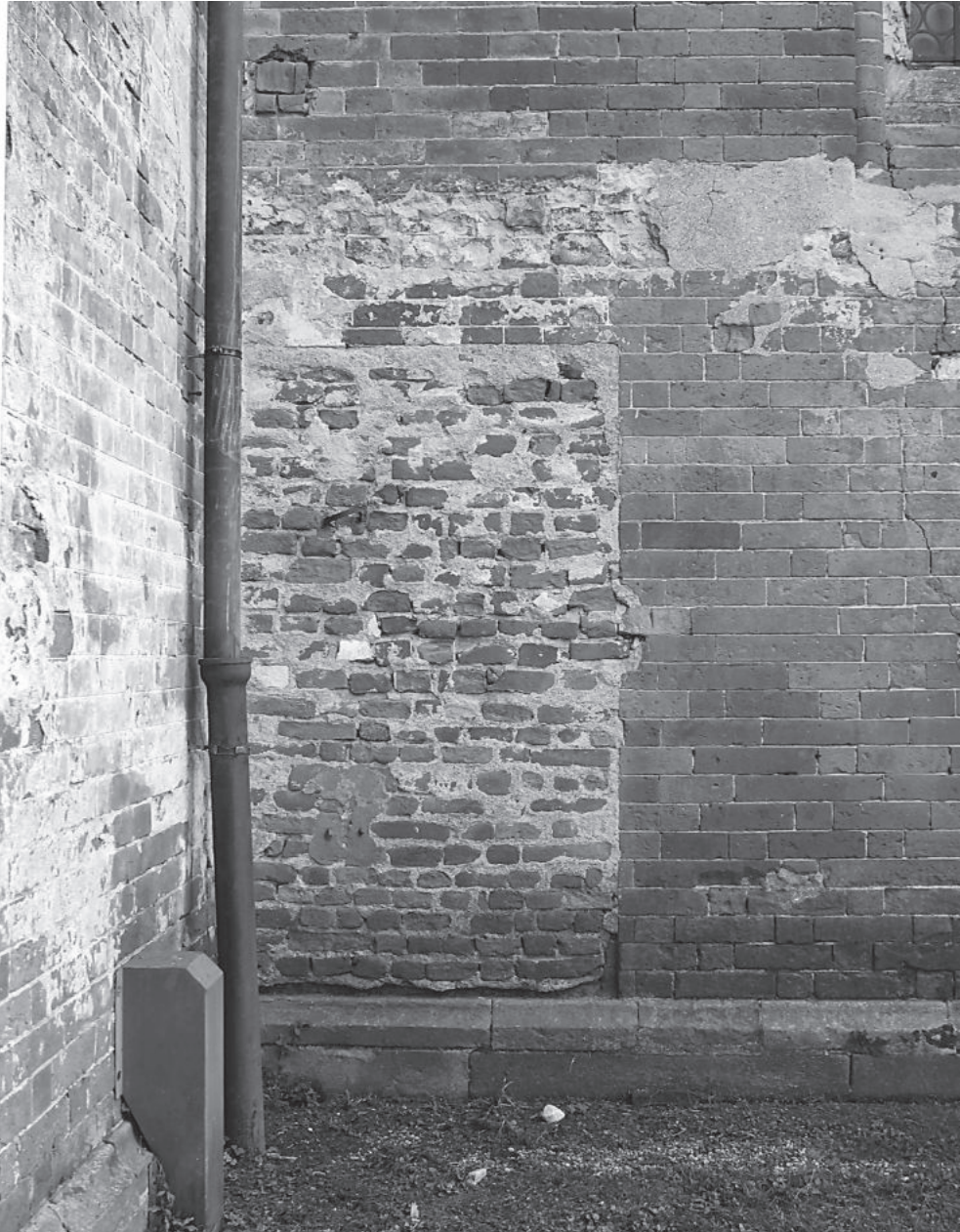
Fig. 10. Traccia di apertura tamponata. Fronte est cappella maggiore braccio settentrionale del transetto.
