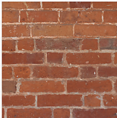
Muratura tipo 7, di ripristino: fase di restauro Prima metà XX secolo: post 1930 - ante 1955 Chostro
