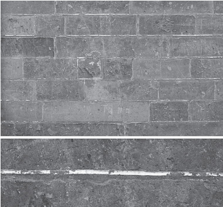
Fig. 4. Dettagli muratura. Fronte est absidale.
