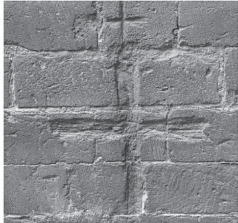
Terzo contrafforte, lato sud
