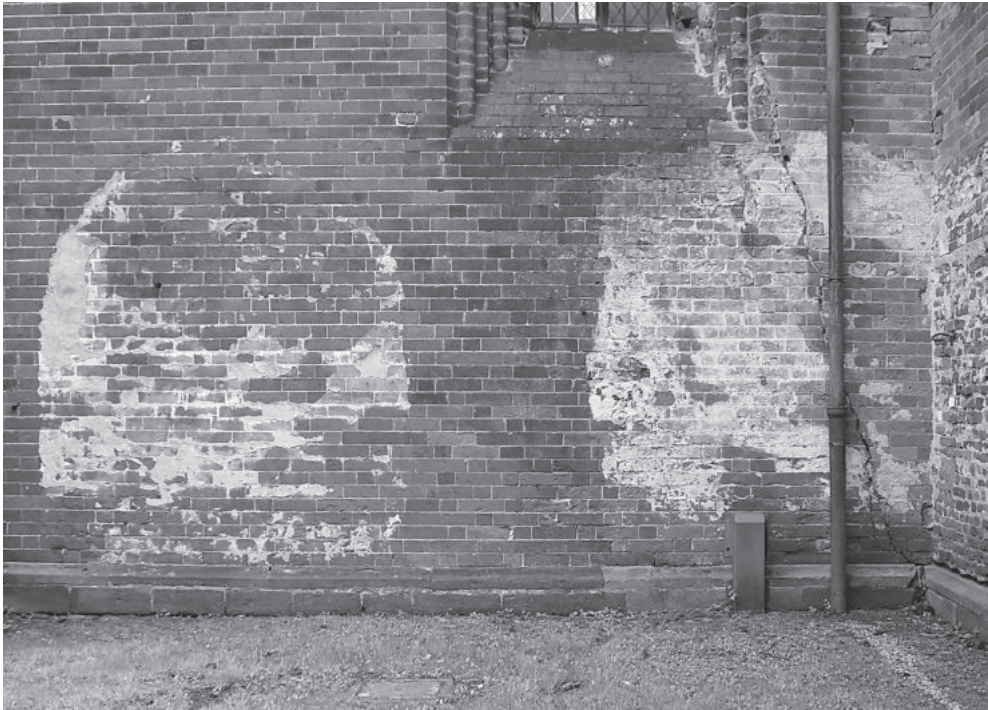
Fig. 9. Tracce di arcate. Fronte nord absidale.
