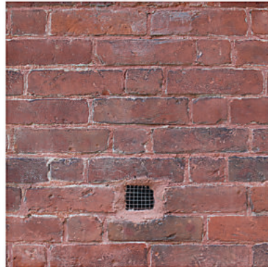
Muratura tipo 4: fase II medievale Prima metà XV secolo: 1407 ca. Torre campanaria
