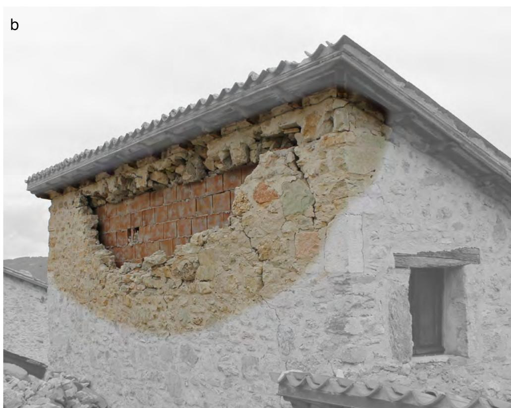
Fig. 4. Danno per interventi strutturali su murature non rinforzate: a) disgregazione e ribaltamento della parete per irrigidimento della copertura (Nocelleto di Castelsantangelo sul Nera, MC); b) scorrimento del solaio irrigidito (Campi Alto di Norcia) (foto ed elaborazioni autore).
