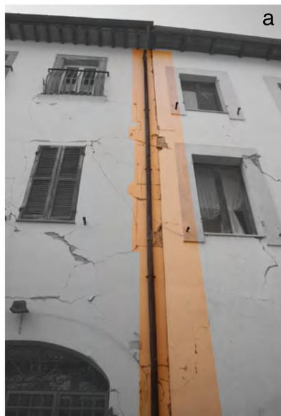
Fig. 2. Danno per trasformazioni della configurazione urbana: a) martellamento tra unità adiacenti e lesioni nel cantonale annegato sotto l'intonaco (Camerino, MC); b) ribaltamento di facciata non ammortata di unità di intasamento (Noceria di Castelsantangelo sul Nera, MC) (foto ed elaborazioni autore).
