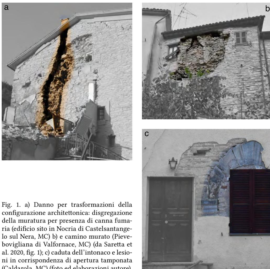
Fig. 1. a) Danno per trasformazioni della configurazione architettonica: disgregazione della muratura per presenza di canna fumaria (edificio sito in Nocria di Castelsantangelo sul Nera, MC) b) e camino murato (Pievobovigliana di Valfornace, MC) (da Saretta et al. 2020, fig. 1); c) caduta dell'intonaco e lesioni in corrispondenza di apertura tamponata (Caldarola, MC) (foto ed elaborazioni autore).
