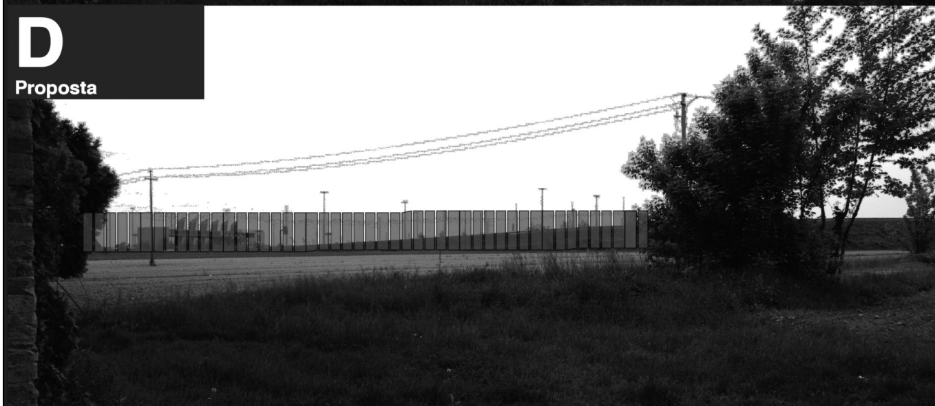
Figura 13 - Villa Braida, Mogliano Veneto. Esempio di mascheramento e segnalazione.
