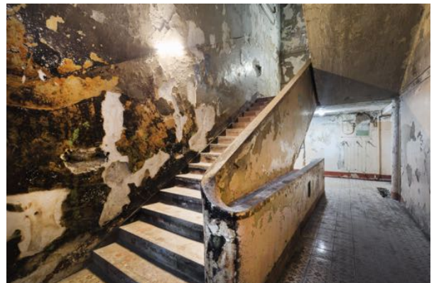
Fig. 8 - Casa del Narkomfin prima del restauro. 2016. Foto Roberto Conte © Roberto Conte
