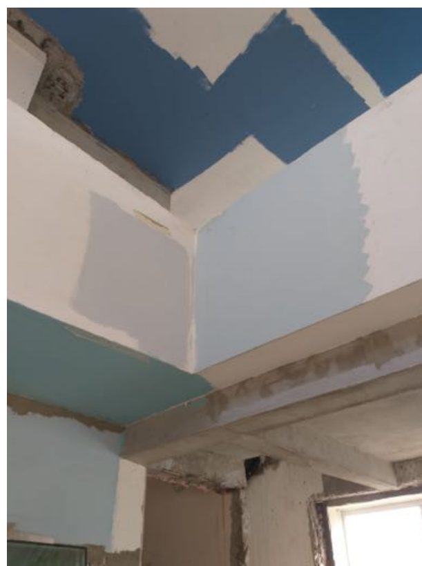
Fig. 12 - Casa del Narkomfin in corso di restauro. Ex-appartamento di Miljutin. Prove del colore. Ottobre 2019. Foto Anna Vyazemtseva.
