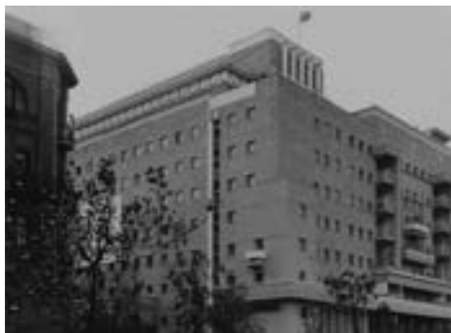
Fig. 3 - La Casa Narkomtjuzprom, 1936-1937, in A. Selivanova, Sovetskoe ar-deko, ili Čto takoe postkonstruktivizm .
