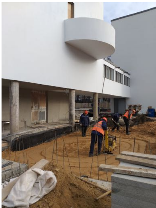
Fig. 9 - Casa del Narkomfin in corso di restauro. Ottobre 2019. Foto Anna Vyazemtseva.
