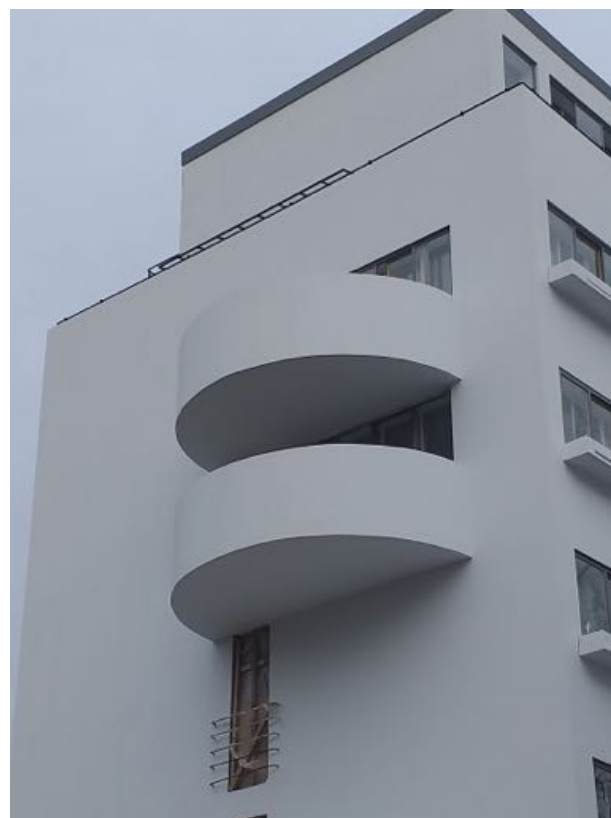
Fig. 10 - Casa del Narkomfin in corso di restauro. Ottobre 2019. Foto Anna Vyazemtseva.
