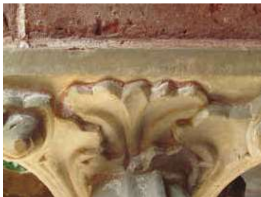
Fig. 1 - Staffarda, abbazia di Santa Maria, capitello marmoreo del chiostro con tracce di finitura dei giunti e cromie a evidenziare i profili scultorei (foto di S. Beltramo, 2017-18).
