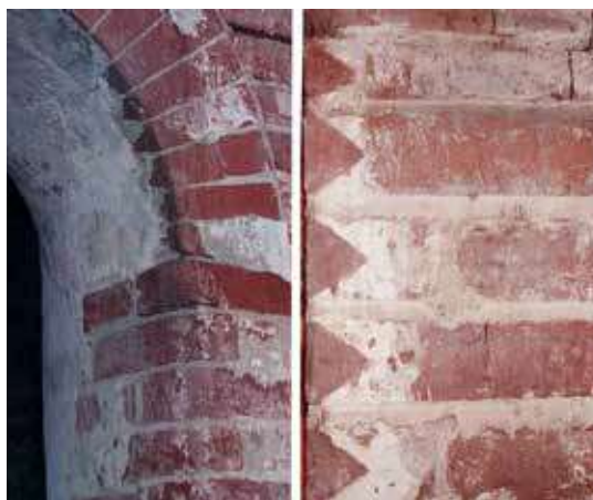
Fig. 3 - A destra: Staffarda, abbazia di Santa Maria, refettorio, portale di accesso al pulpito con decorazione a intonaco a dente di sega. A sinistra: Morimondo, abbazia di Santa Maria, chiesa, particolare dell'apertura conservata nell'area absidale al di sotto del chiostro ligneo (foto di S. Beltramo, 2017-18).
