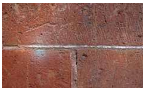
Fig. 10 - Vercelli, canonica di Sant'Andrea, trattamento superficiale dei giunti di malta (foto di I. Papa, maggio 2019).
