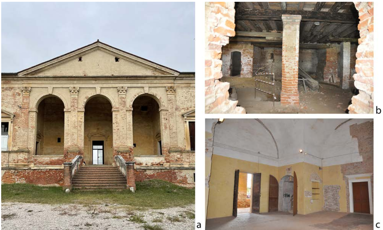
Fig. 1. Vicenza, Villa Gazzotti. a) prospetto sud (foto N. dal Maso 2021); b) veduta del piano seminterrato, in corrispondenza del salone centrale; c) veduta del salone centrale (foto C. Miolo 2021).
