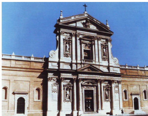
Fig. 14 - Prospetto della Chiesa e del Convento di S. Susanna
