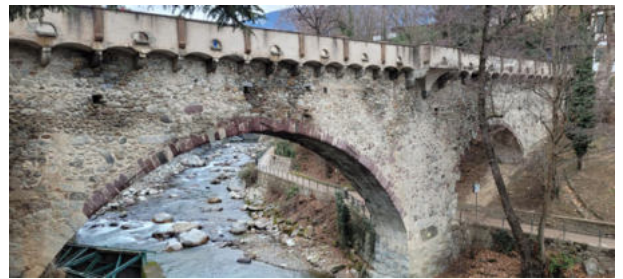
Fig. 2 - Il ponte romano di Merano
