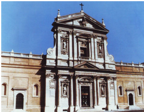
Fig. 1 - Prospetto della Chiesa e del Convento di S. Susanna
