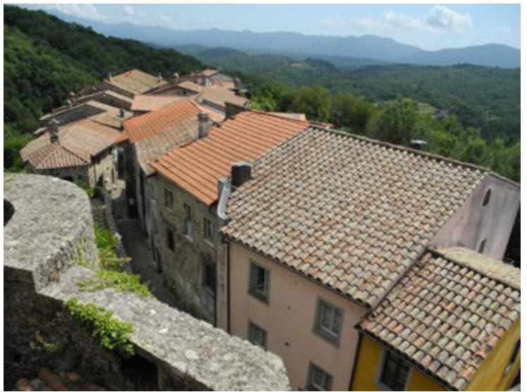
Fig. 6 - Coperture del borgo
