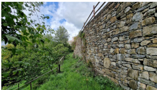
Fig. 23 - Pareti di contenimento
