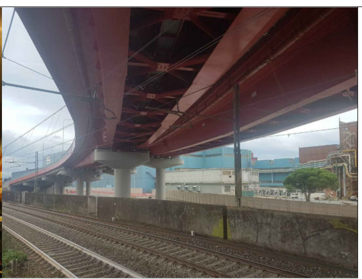
VIADOTTO STRADA A MARE GENOVA
