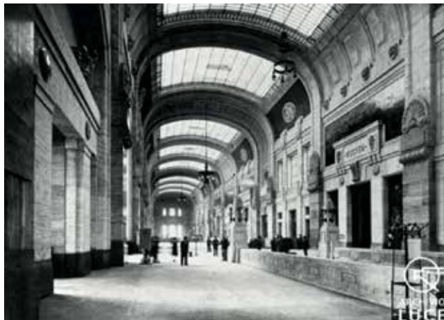
Fig.2 Stazione di Milano. (Fonte: Archivio Istituto Luce)
