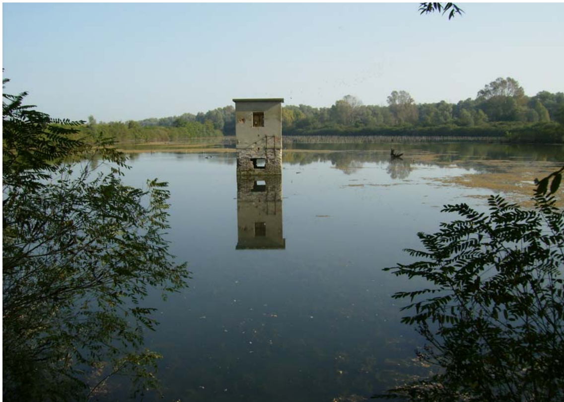
Fig. 4.4 Par effet de la subsidence, des bâtiments ont été submergés.
