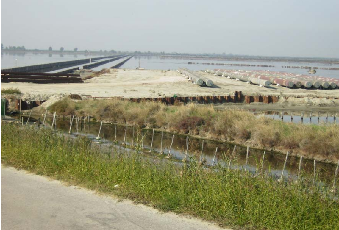
Fig. 4.12 Chantier du gazoduc, relié au terminal gazier Edison au large de Porto Levante.
