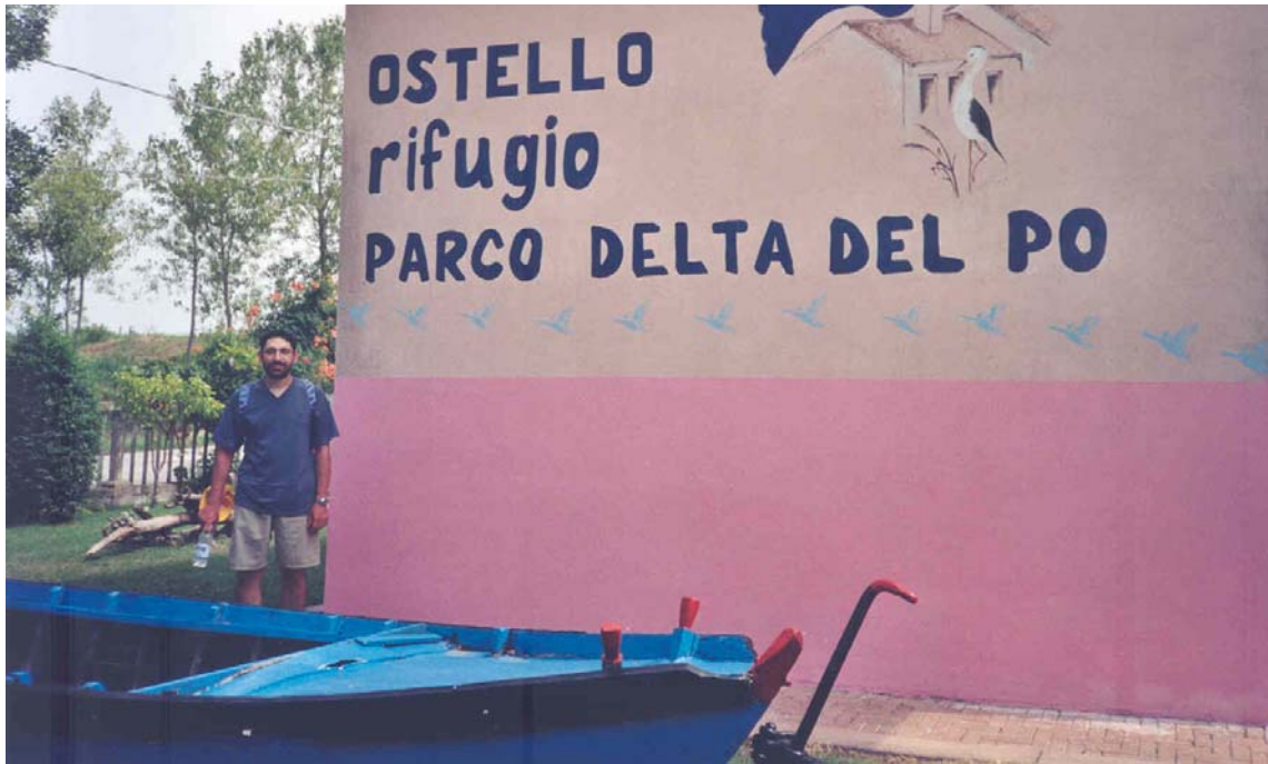
Fig. 6.12 Dans la partie basse du mur extérieur, a peinture à été refaite à l'auberge de jeunesse « Ostello rifugio Parco Delta Po », à Santa Giulia, à cause des dégâts provoqués par la montée de l'eau. Les arbres derrière l'immeuble correspondent au berges du Pô di Gnocca.
