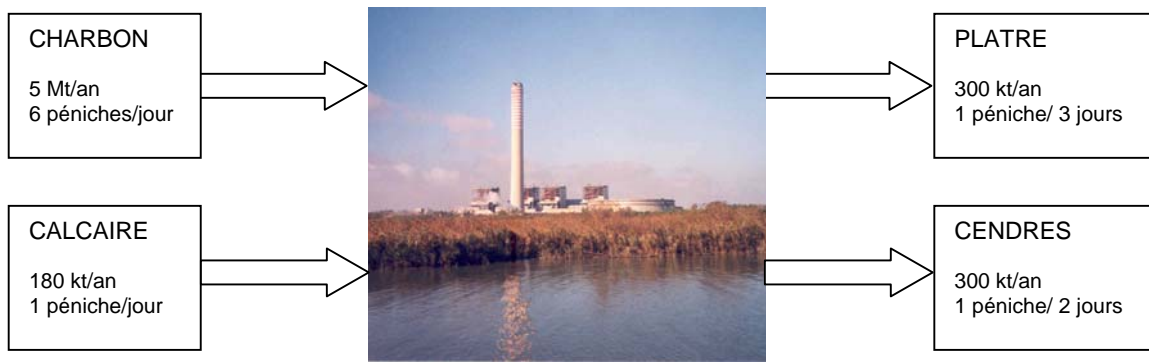
Fig. 6.9 Prévion du transport sur péniche fluviomaritime, après la reconversion au charbon de la centrale électrique Enel. Chaque péniche a une portée de 3000 et sera active 300 jours par an. (source : Enel, élaboration personnelle).
