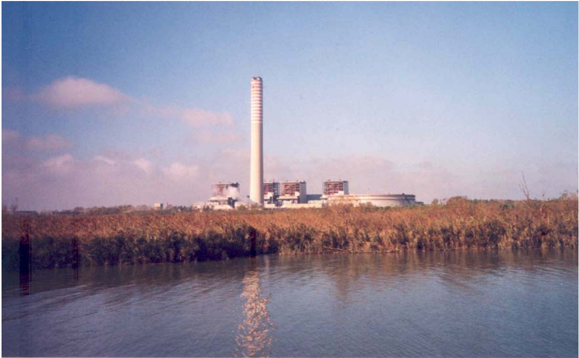
Fig. 4.11 La centrale thermoélectrique Enel de Polesine Camerini.
