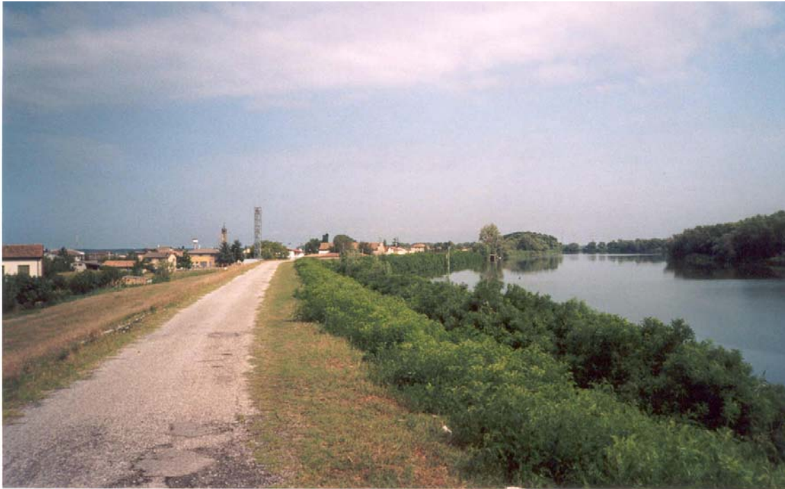
Fig. 4.3 Voie sur berges dans le Delta du Pô. Le niveau de l'eau est plus élevé que celui de la campagne.
