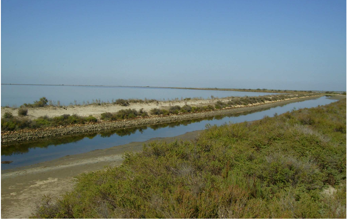
Fig. 7.5 La digue à la mer.
