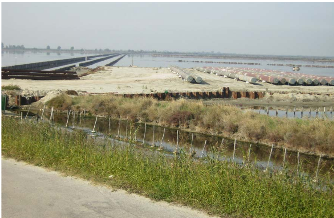
Fig. 6.10 Chantier du futur Gazoduc (Valle Bagliona).
