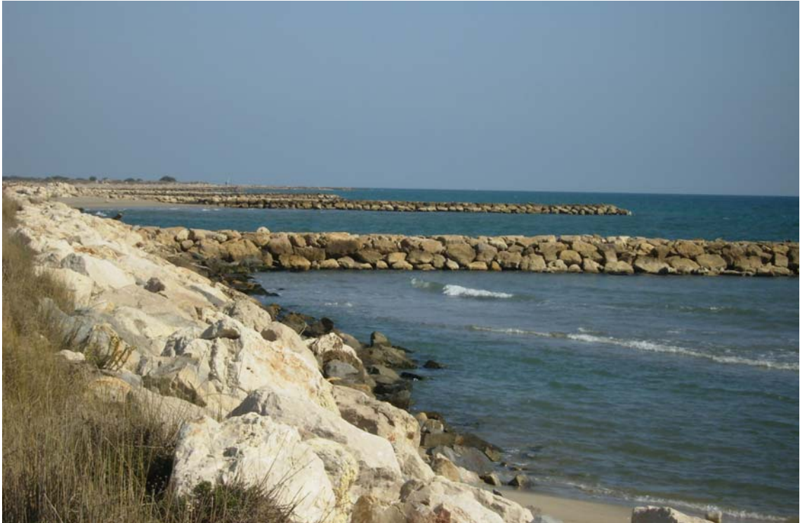
Fig. 3.4 Un trait de côte artificialisé par la présence massive d'épis de protection, à les Saintes Maires, en Camargue.
