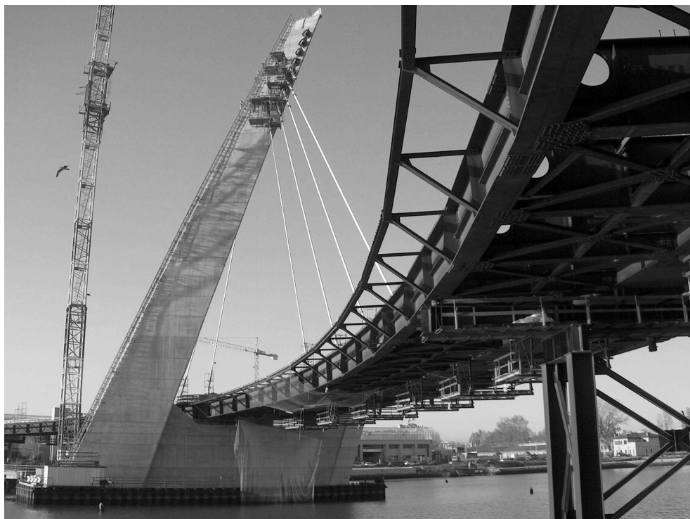
Figura 4.2: Fotografia del ponte analizzato in fase di costruzione.
