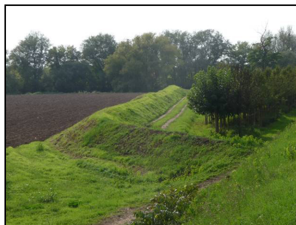
Figura 5.24 - Argini secondari presenti nel tratto Acquanegra.
