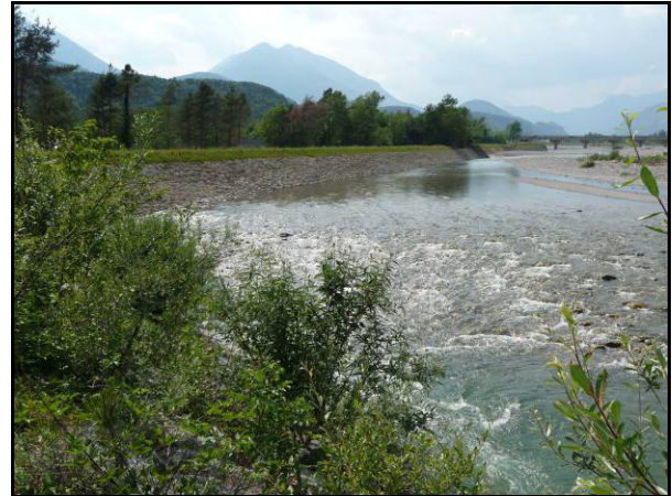
Figura 5.2 - Argini presenti nel tratto Cavazzo.
