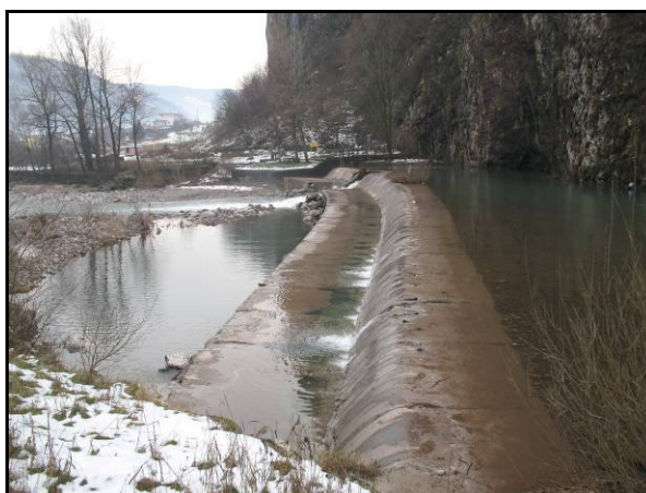
Figura 5.20 - Traversa localizzata all'estremità di monte del tratto Sabbio.
