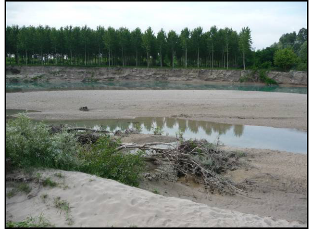
Figura 5.6 - Detrito legnoso depositato nell'alveo ed erosione spondale nel tratto Latisana.
