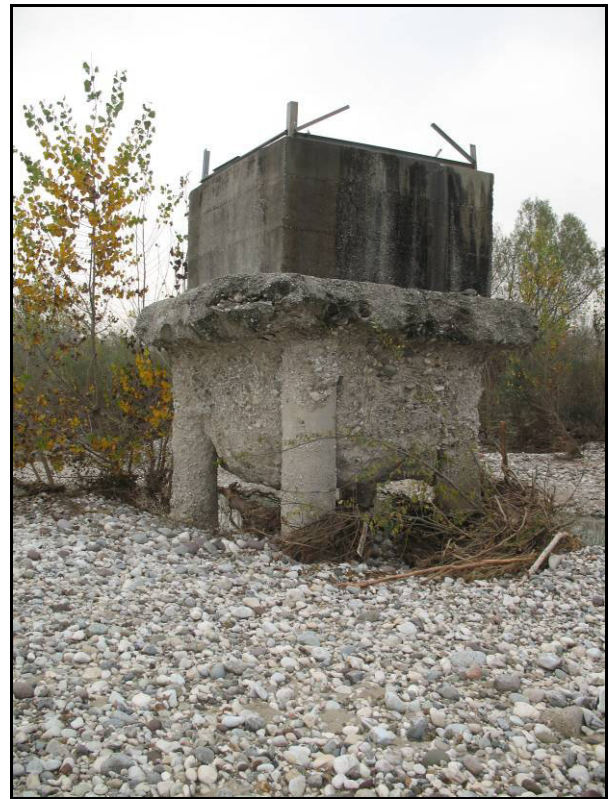
Figura 5.10 - Basamento sottoscalato di un traliccio, indicativo dell'intensità dell'incisione in questo tratto.
