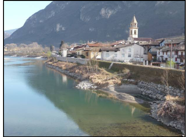
Figura 5.14 - Argine, difese di sponda e pennelli nei pressi dell'abitato di Borghetto d'Avio.
