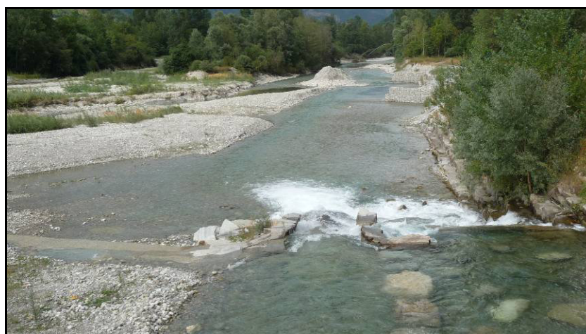
Figura 5.32 - Soglia e pennelli localizzati al termine del tratto Demonte.
