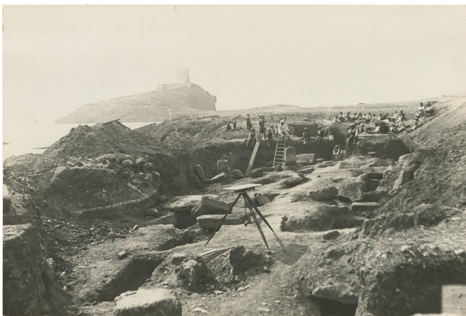
Fig. 9. Nora (CA): fasi di sterro della necropoli punica orientale nel 1891 (ASABPCA, n. inv. 1523). Foto della Soprintendenza Archeologia Belle Arti Paesaggio di Cagliari – Archivio fotografico, autorizzazione prot. 15636 del 27 luglio 2017.
