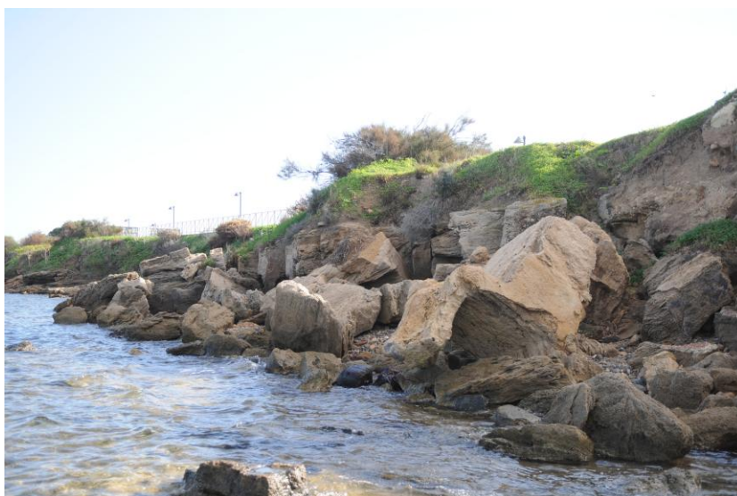
Fig. 6. Nora (CA): ipogei punici in crollo lungo il costone roccioso di levante (foto autore).
